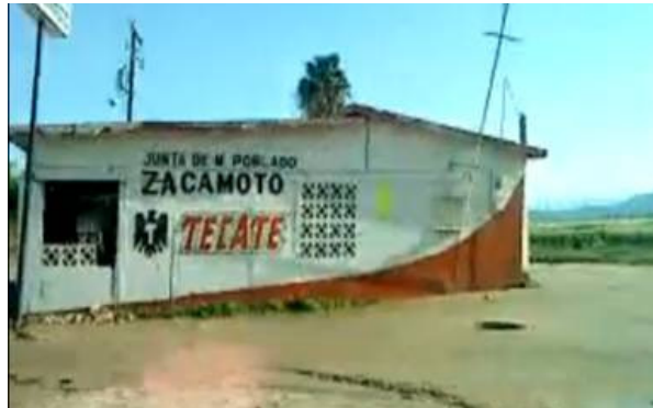
Figura B4. Ejemplo de una vivienda inclinada
