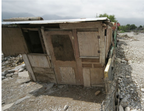
Figura 3.6 Vivienda con madera como material de construcción
