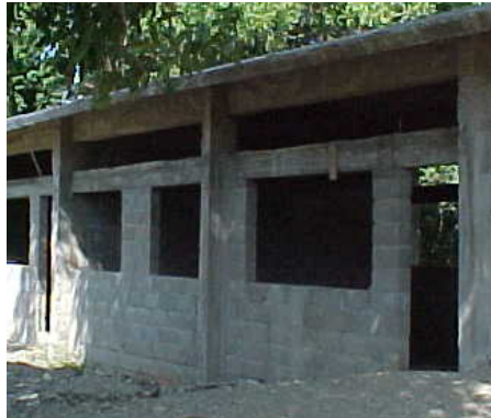
Figura 3.14 Vivienda con block como material de muro
