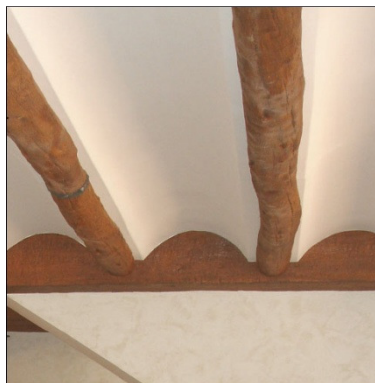
Figura 3.18 Vivienda con terrado con vigería como material de techo
