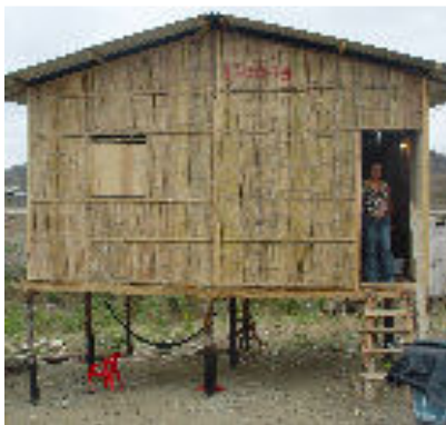
Figura 3.4 Vivienda con bambú como material de construcción
