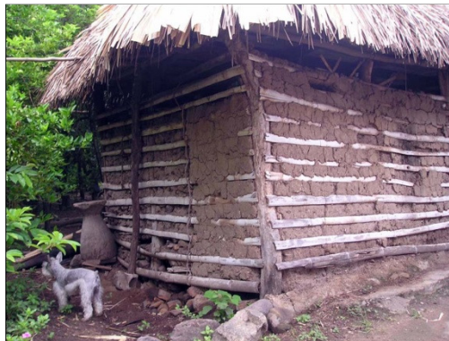
Figura 3.7 Vivienda con embarro como material de muro
