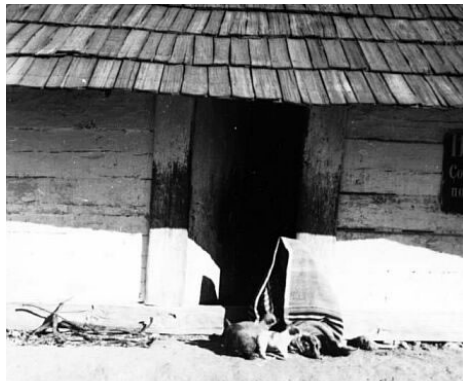
Figura 3.12 Vivienda con tejamanil como material de construcción
