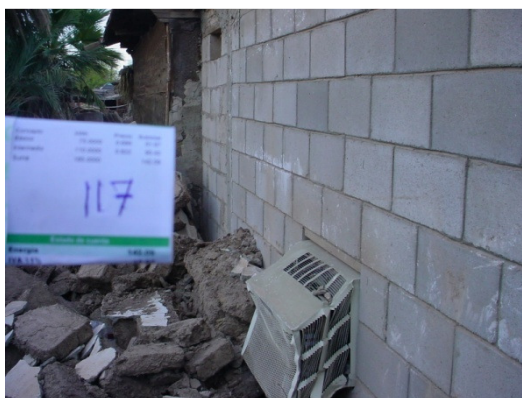
Figura 4.7 Vivienda conformada con block en los muros
