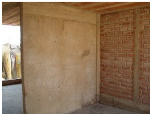
Figura 3.16 Vivienda con concreto como material de muro
