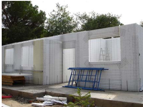
Figura 3.10 Vivienda con panel como material de construcción
