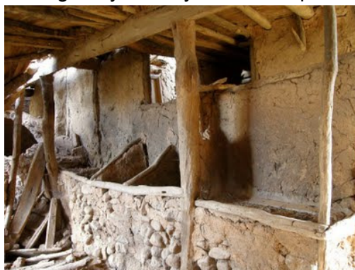
Figura 3.8 Vivienda con adobe como material de muro
