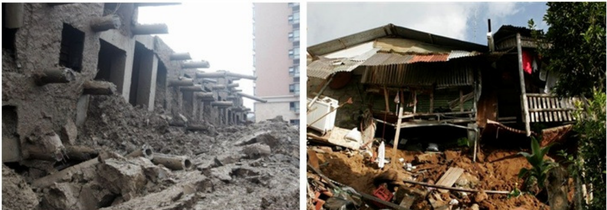
Figura B10. Ejemplo de ruptura y desplome de una cimentación
