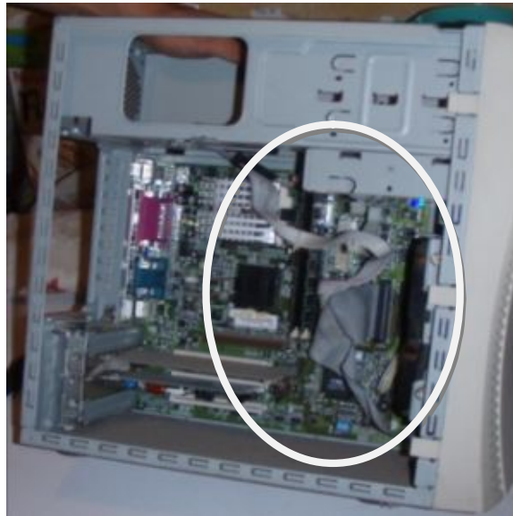
Figura 4.14 Cables ID en el CPU
