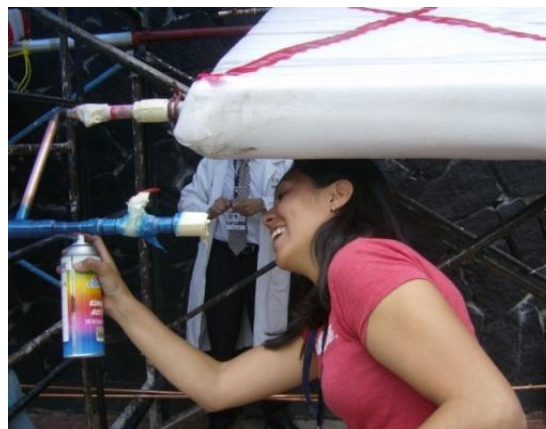
FIGURA 3.8. Identificación de tuberías de entrada
