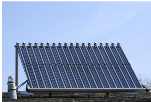
FIGURA 2.3 Colector solar de tubos de vacío
