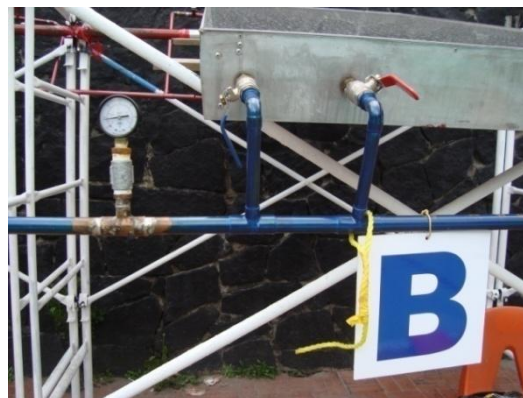
FIGURA 3.22. Instalación de manómetros a la entrada de cada colector.
