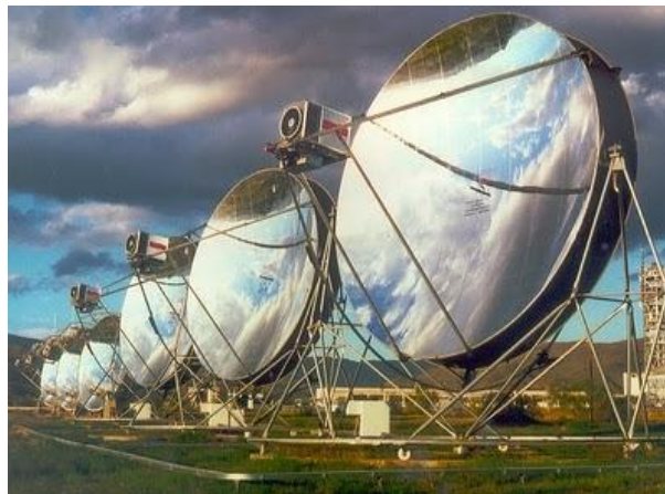
FIGURA 2.13 Concentrador dinámico de paraboloides de revolución
