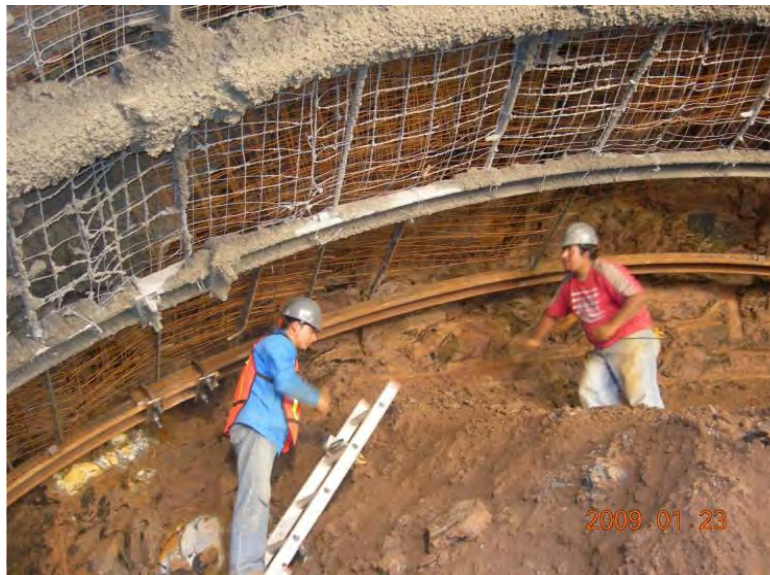
Imagen 13 .Colocación de malla electrosoldada
