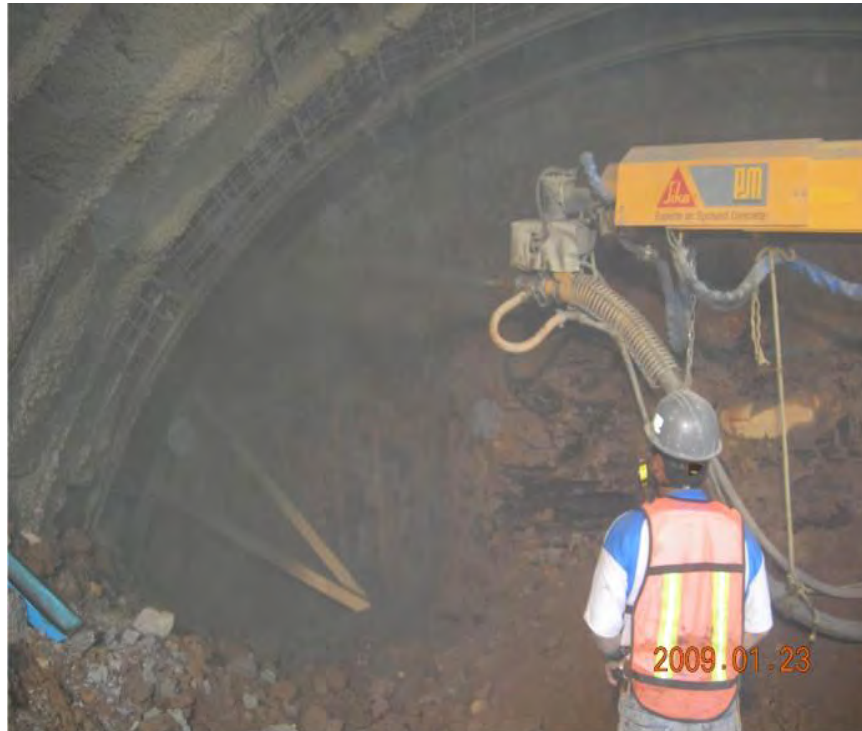
Imagen 14 .Concreto lanzado en portal.
