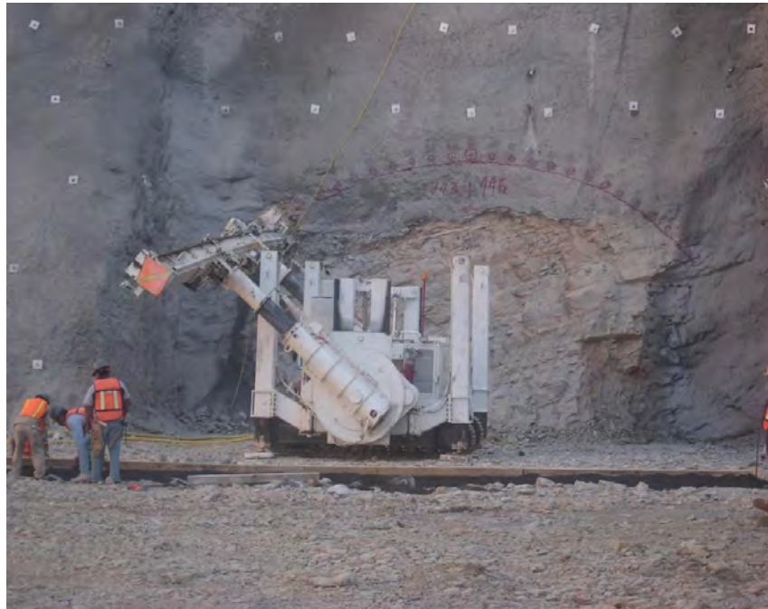
Imagen 15. Ejecución del enfilaje.
