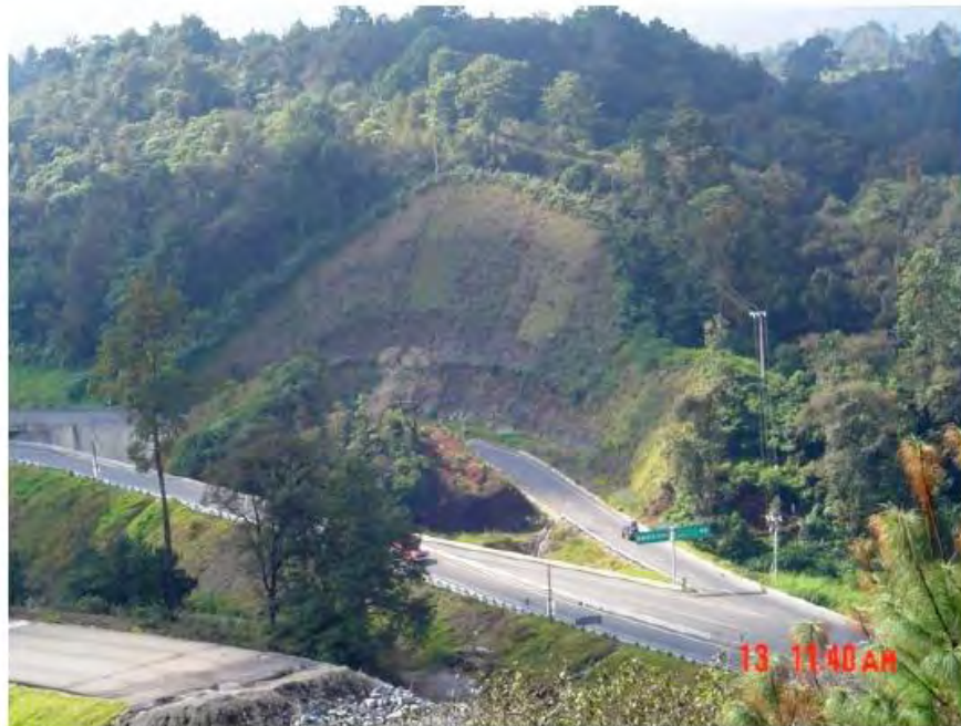
Fotografía 3. Detalle de excavaciones en corte abierto en la zona en materiales similares a los del portal de entrada México – Túneles Huachinango.
