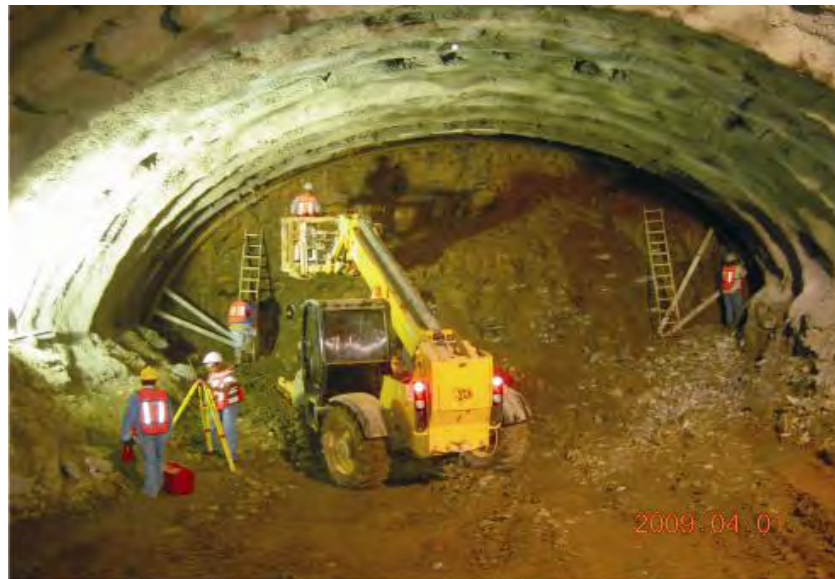
Imagen10 .Excavación en la galería izquierda
