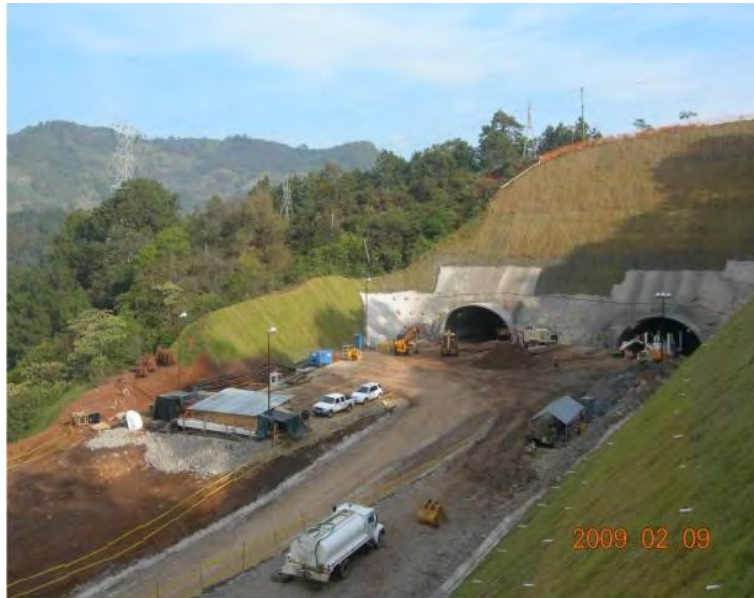
Imagen 19. Aspecto general del túnel Huauchinango.
