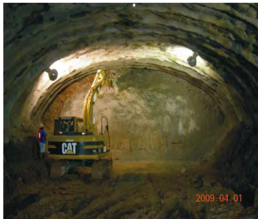
Imagen 11 .Excavación en la galería derecha
