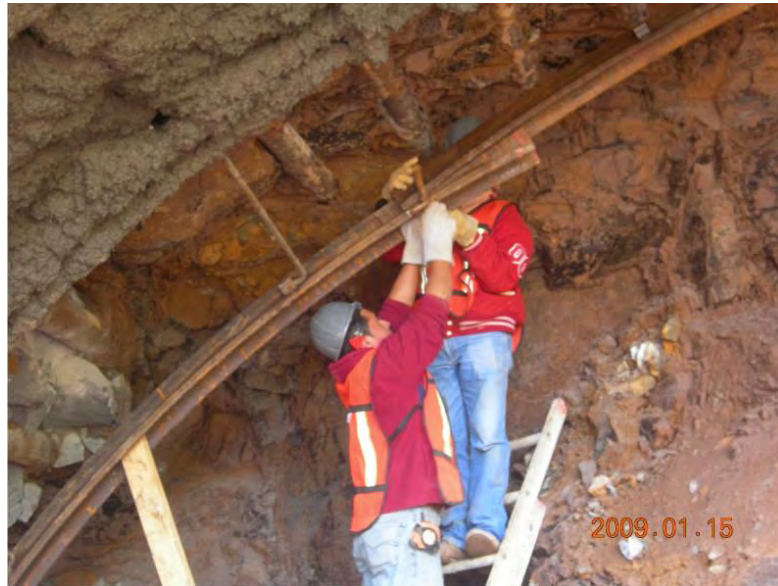
Imagen 12 .Colocación de marco metálico.
