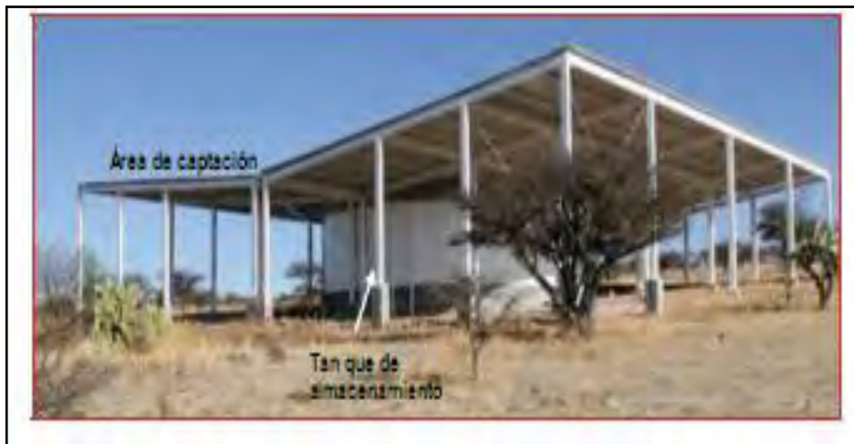
Figura 4.3 Ejemplo de Techo cuenca en la Comunidad del Tecongo, Aguascalientes (D. Phillips y col., 2006).
