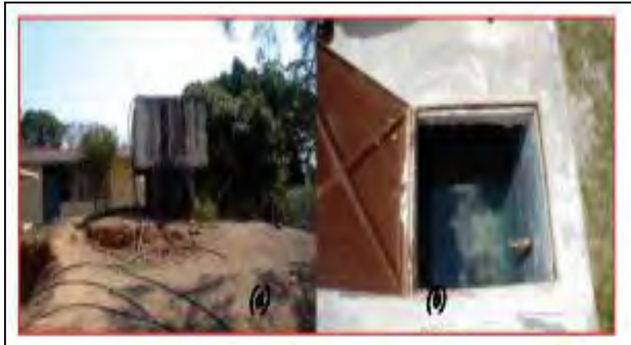
Figura 4.10 (a) Cisterna de cemento tabique: escuela primaria de Acapulco, (b) y tapa de protección, Estado de México. (D. Phillips y col., 2006)
