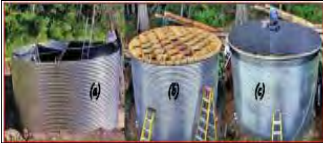
Figura 4.12 (a) Ensamblado de las hojas de lámina galvanizada con tornillos, (b) Estructura para el techo del tanque y (c) Colocación de material impermeable para evitar las pérdidas del agua por evaporación. (a) (b) (c). (D. Phillips y col., 2006)
