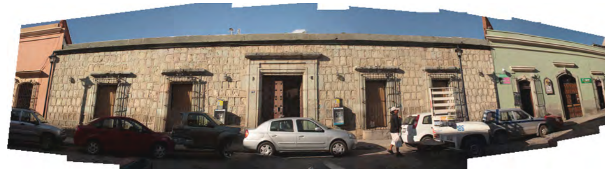
5. Vista de los inmuebles al costado derecho sobre la calle Mariano Matamoros
