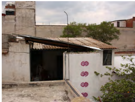
Vista desde el techo a la conexión entre los edificios.
