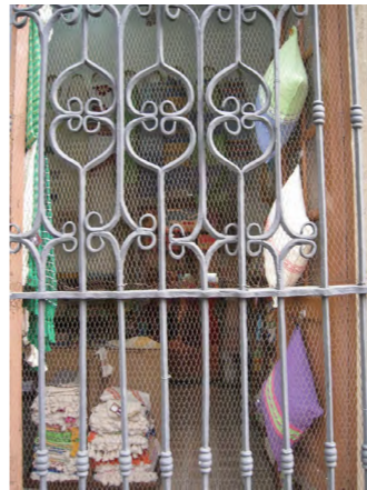
Las ventanas, herrería y malla para evitar los robos
