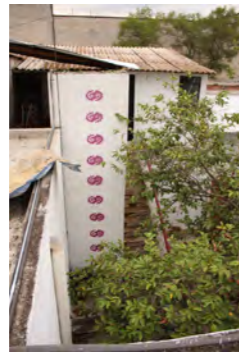
Escaleras a la azotea
