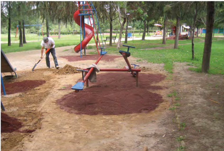
Trabajos de mantenimiento.
