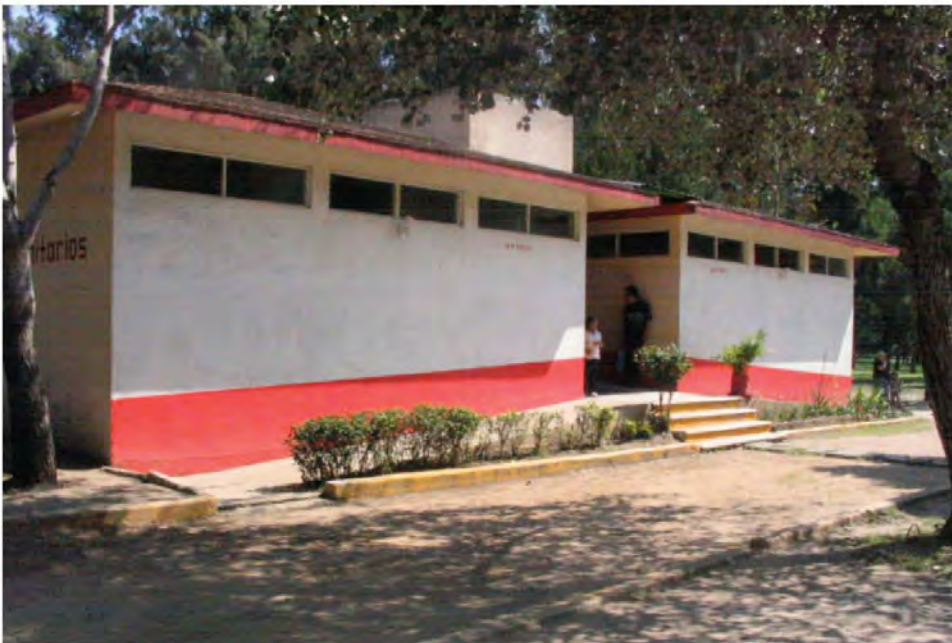
7. Baños públicos centrales.
