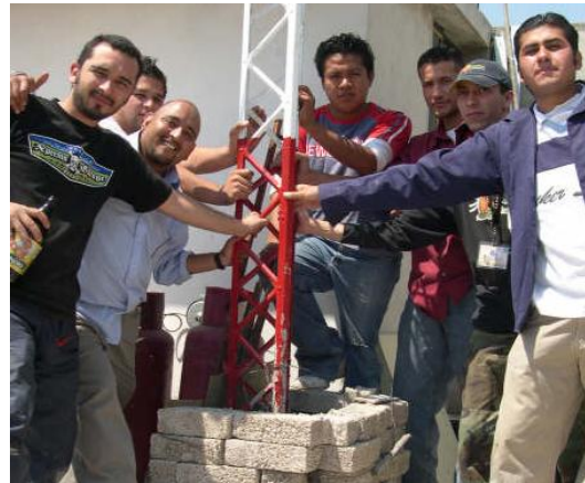
Colocación de la torre
