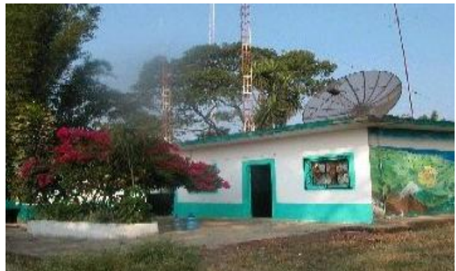
Instalaciones de la planta transmisora
