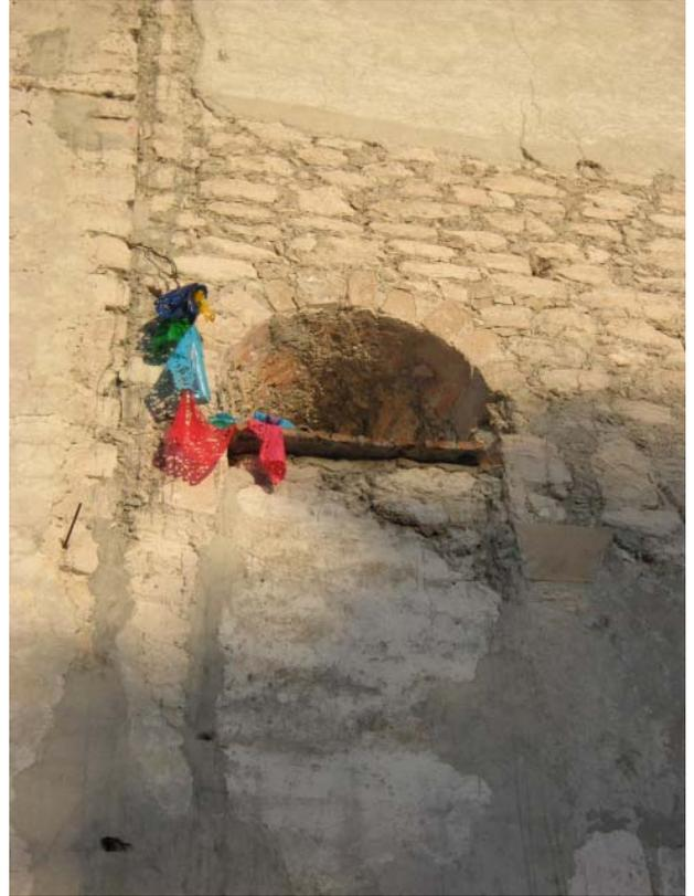
Figs 36 y 37. Torre campanario del templo de Huatlatlauca. Obsérvese la diferencia en los materiales constructivos y como se adicionó esta torre campanario sobre algún elemento arquitectónico anterior en donde se puede observar una ventana cegada. Fotos: JAVT
