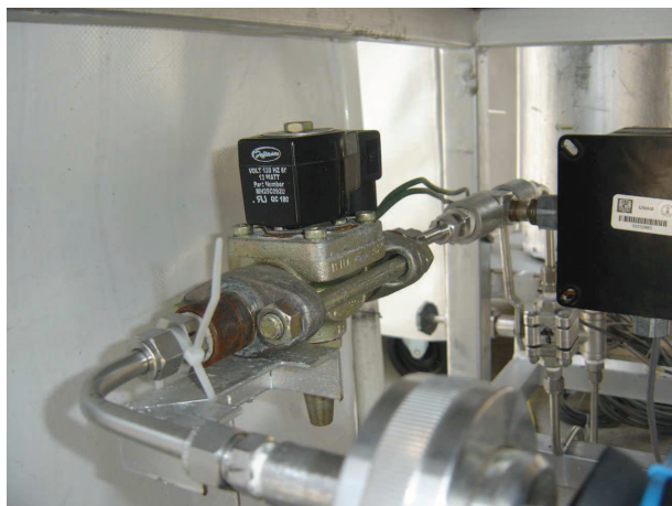
Fig. 2.6. Instalación de la válvula de control tipo solenoide para el sistema de refrigeración solar intermitente.
