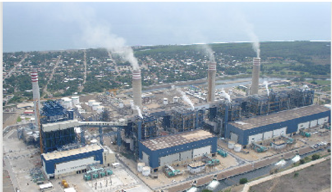
Imagen 3.5. Vista general de la Central Termoelectrica Plutarco Elías Calles (incluido el nuevo generador) cada chimenea corresponde a dos unidades de generación
