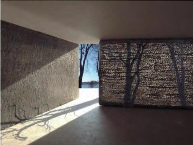
Vista de un muro construido con LiTraCon.
