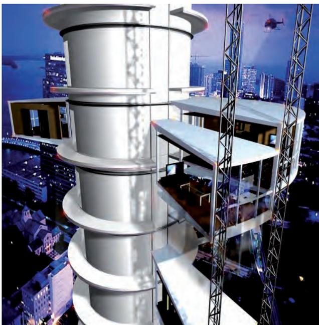
*Detalle del armado modular por habitación para construir el edificio dinámico.*
