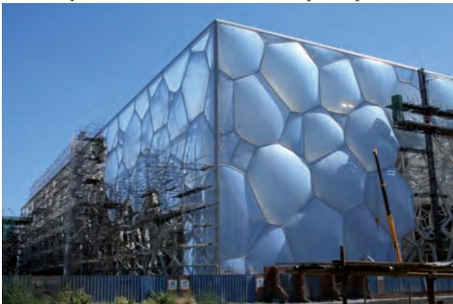
Este material, por su constitución translúcida, permite el uso del "efecto luciérnaga", además su factor de resistencia es enorme, por lo cual cada membrana es capaz de aguantar el peso de un automóvil. Otro beneficio del *ETFE* es que su coeficiente de fricción es bastante fino, por lo cual el polvo no penetra fácilmente, esto hace más fácil su limpieza, incluso una caída de lluvia lo podría dejar sin polvo.
