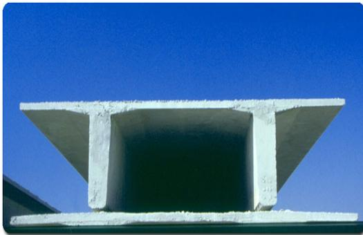
**Fig. 2.89** Losas "TT" Y "T" sencillas.
