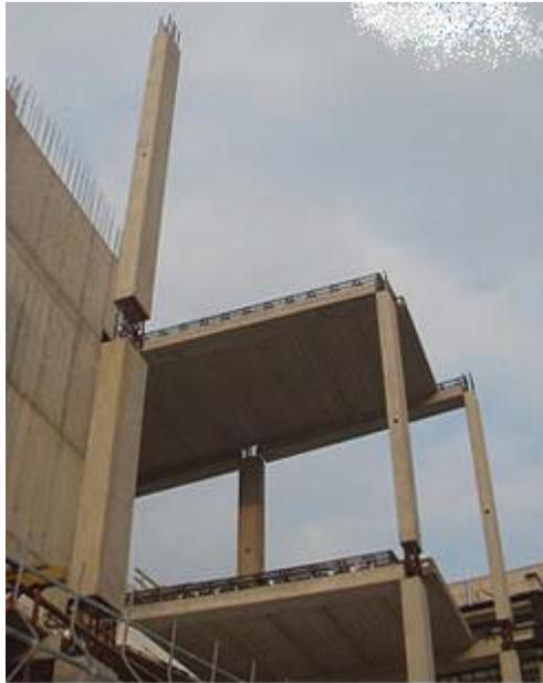
**Fig. 2.91 Edificación a base de elementos prefabricados.**
