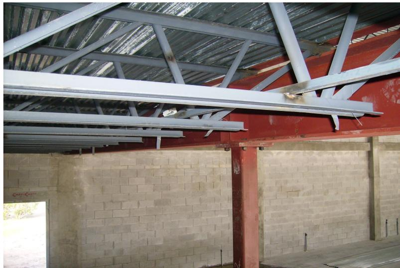
**Fig. 2.73 Sistema de piso de losa de concreto sobre vigas joists**
