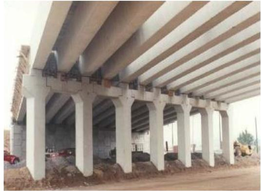
**Fig. 2.88** Trabes portantes pretensadas.
