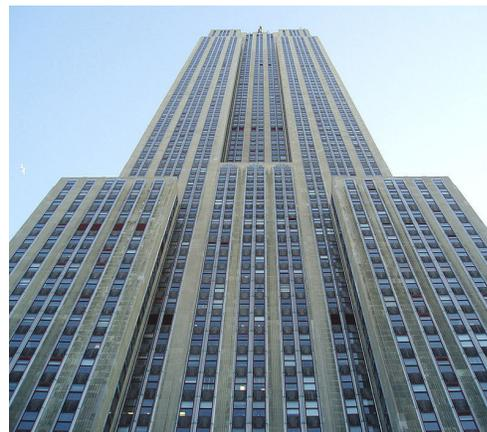
**Fig. 2.75 Estructuración típica a base de marcos rígidos (Empire State Building).**
