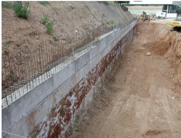
**Fig. 2.56 Muro de contención.**
