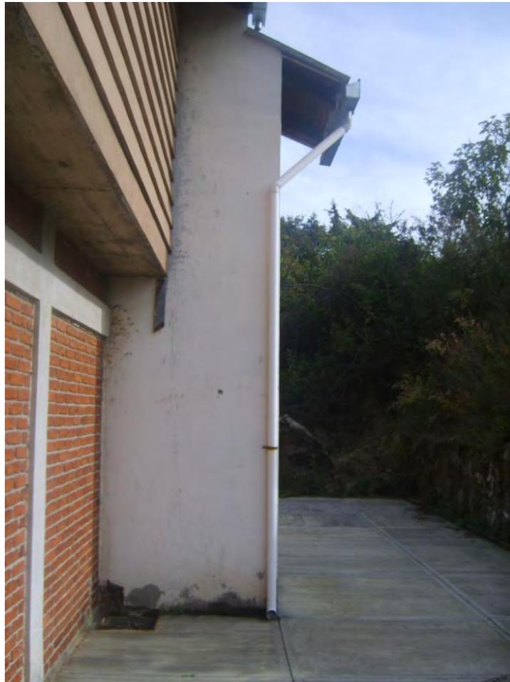
Figura 4.12. Detalle de bajante de agua de lluvia
