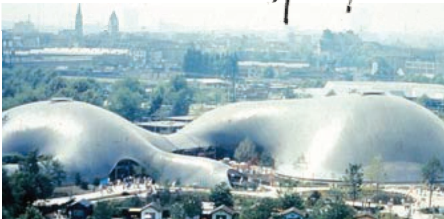
Puntualizando en el proyecto de la sala de exhibiciones de Frei Otto en Mannheim, observamos que la estructura funciona a partir de una red colgante que al invertirla, generaría la forma que se dio a la estructura.
