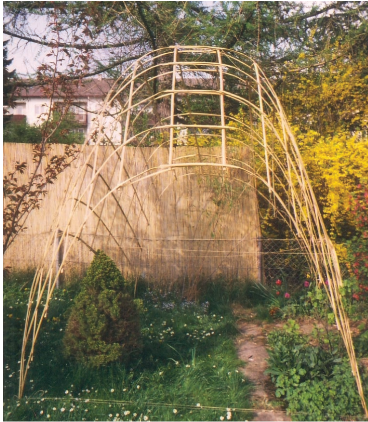
Estudio de cascarón de bambú construido a partir de anticatenarias, Anónimo, Universidad de Stuttgart, Alemania 1991
