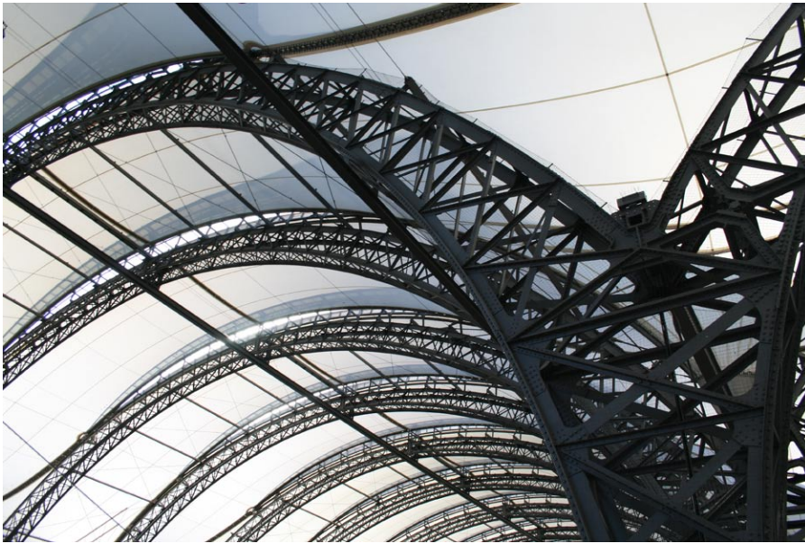
Estación Ferroviaria Norman Foster Dresde, Alemania 2006
