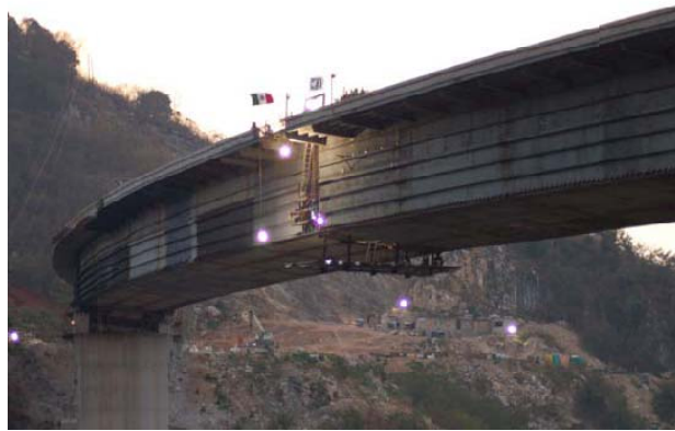
Figura 5.1 Puente San Cristóbal
