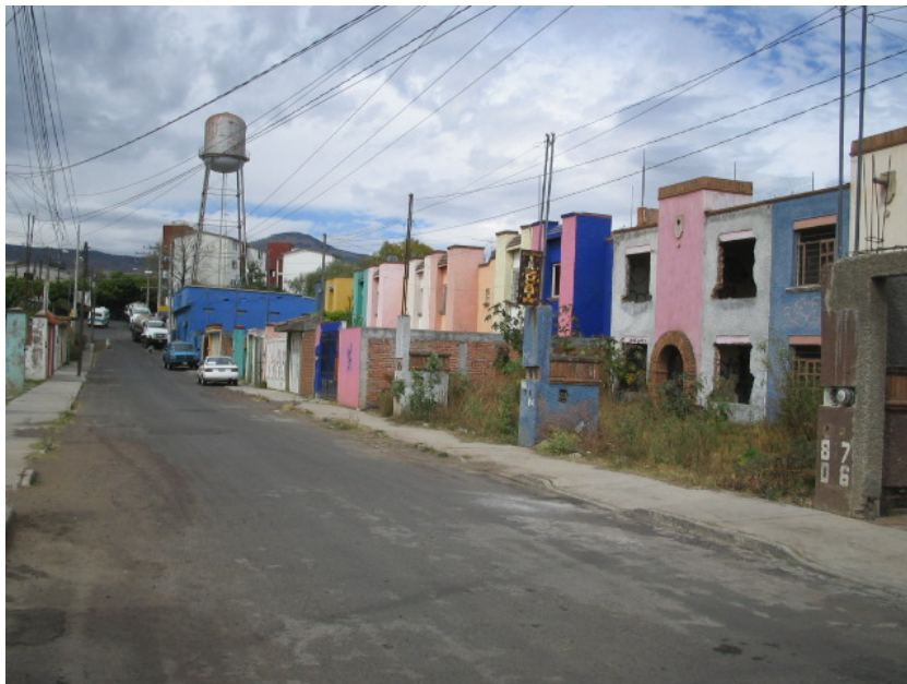
Figura 5.4- La sobreexplotación del acuífero y la falta de planificación de las zonas habitacionales en la Cd. de Morelia provocan la pérdida total de las mismas (Arciniega, 2008).
