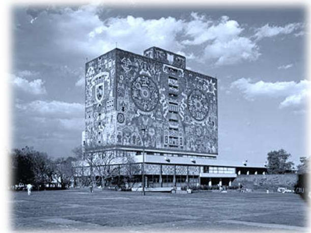
• Biblioteca Central situada en C.U.
