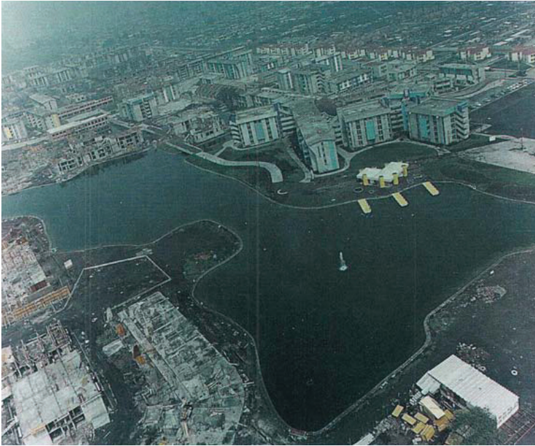
Vista Aérea, Construcción del Conjunto Habitacional “Iztacalco”
