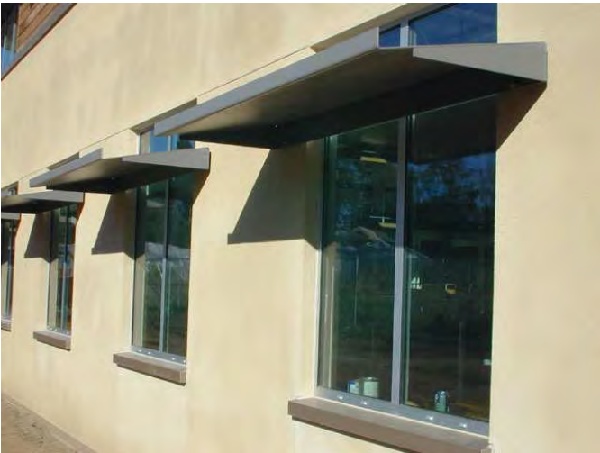
Imágenes: Detalles del sistema de protección de ventanas Fuente: www.dge.stanford.edu
