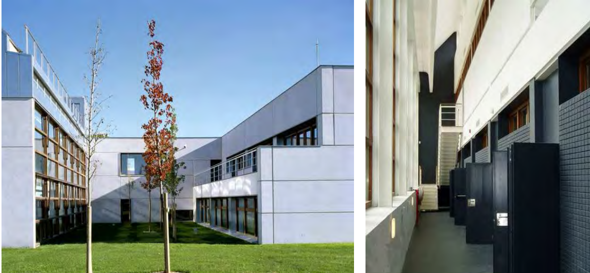
Imágenes: Detalle de patio y corredor de los laboratorios del CENER. Fuente: www.cener.com
