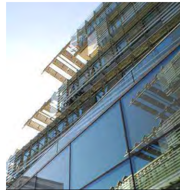
Imagen: Detalle Fachada. Fuente: www.mc.architects.it
