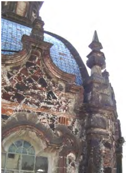
El Carmen 32 detalle de respiradero para vigas de madera cúpula principal
