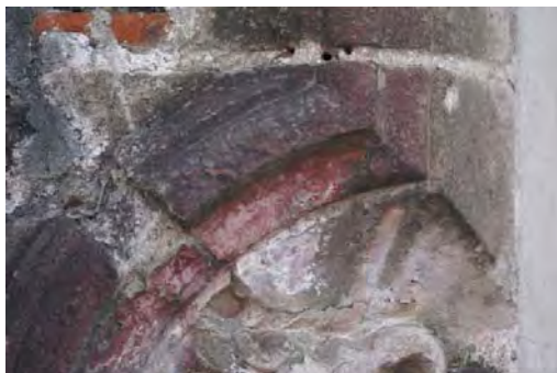
El Carmen 41 deterioro en valvas.
