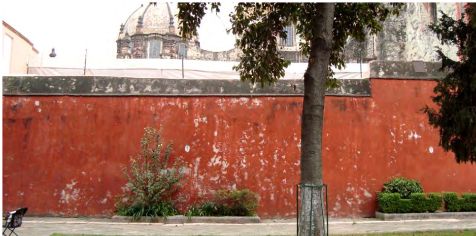
El Carmen 6 muro oriente
