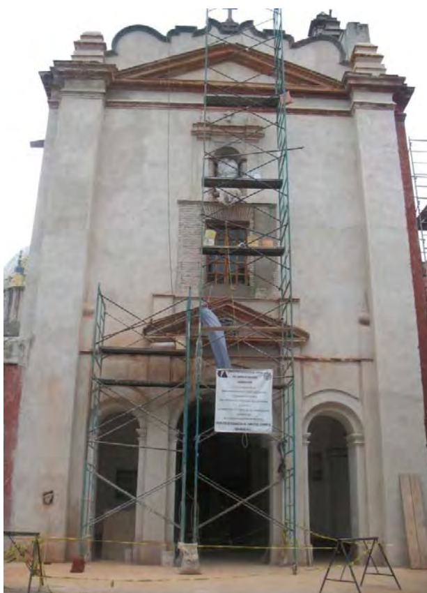
El Carmen 68 inicio de restauración en fachada del templo. Donde se hizo liberación, limpieza por hidrofugación, reintegración de elementos y entibado.
