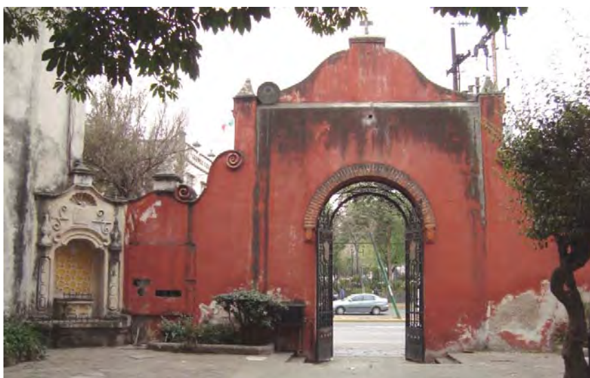
El Carmen 8 actual entrada principal poniente
