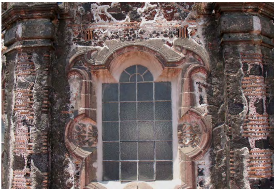
El Carmen 37 ventanas cúpula principal, jabs donde todavía se pueden apreciar las capas de enlucidos anteriores.
