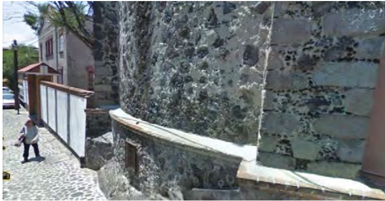
Contexto Urbano 19 Ventilación de la Cripta
