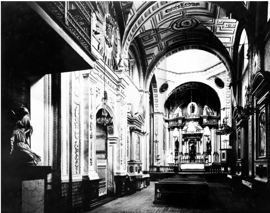
Templo del Carmen fototeca del INAH 1 vista de la nave apuntada hacia el altar.
