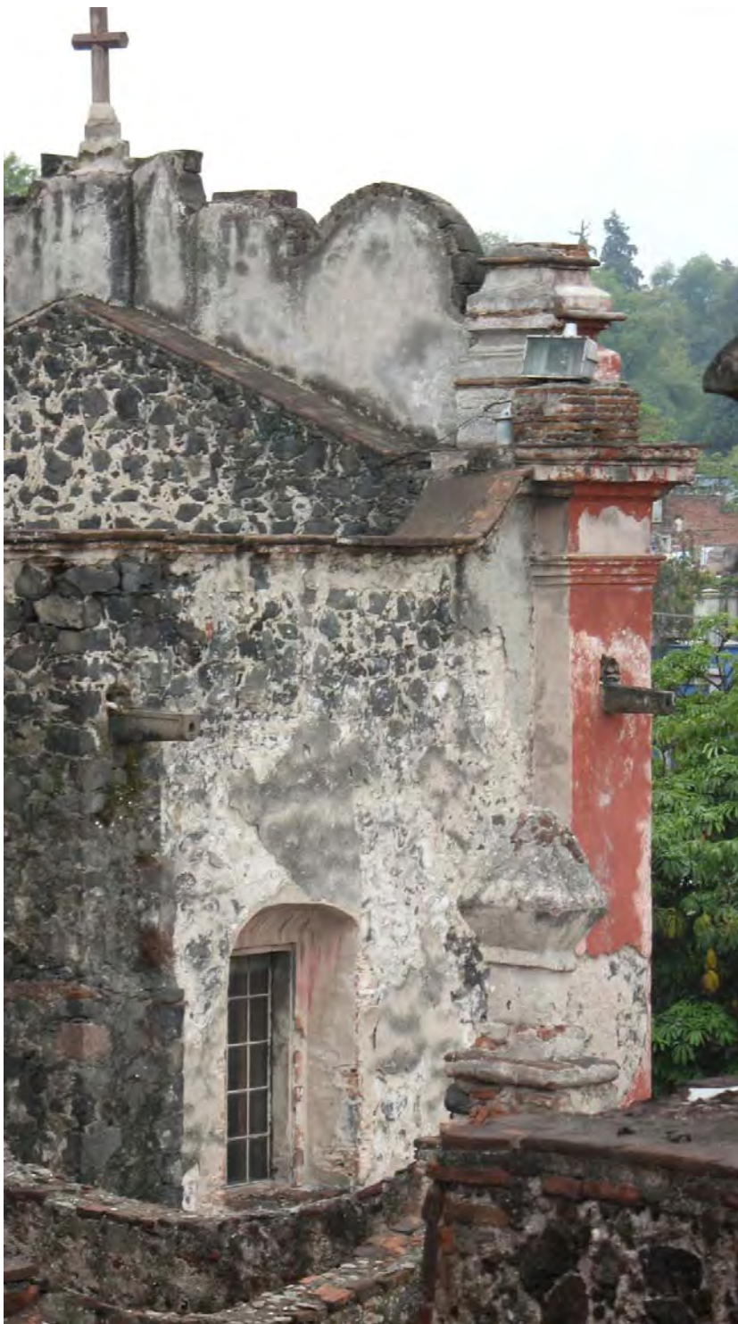
El Carmen 48 vista soslayada donde se muestra el muro norte, ventana del coro y gárgolas; colindante a la casa de las campanas
