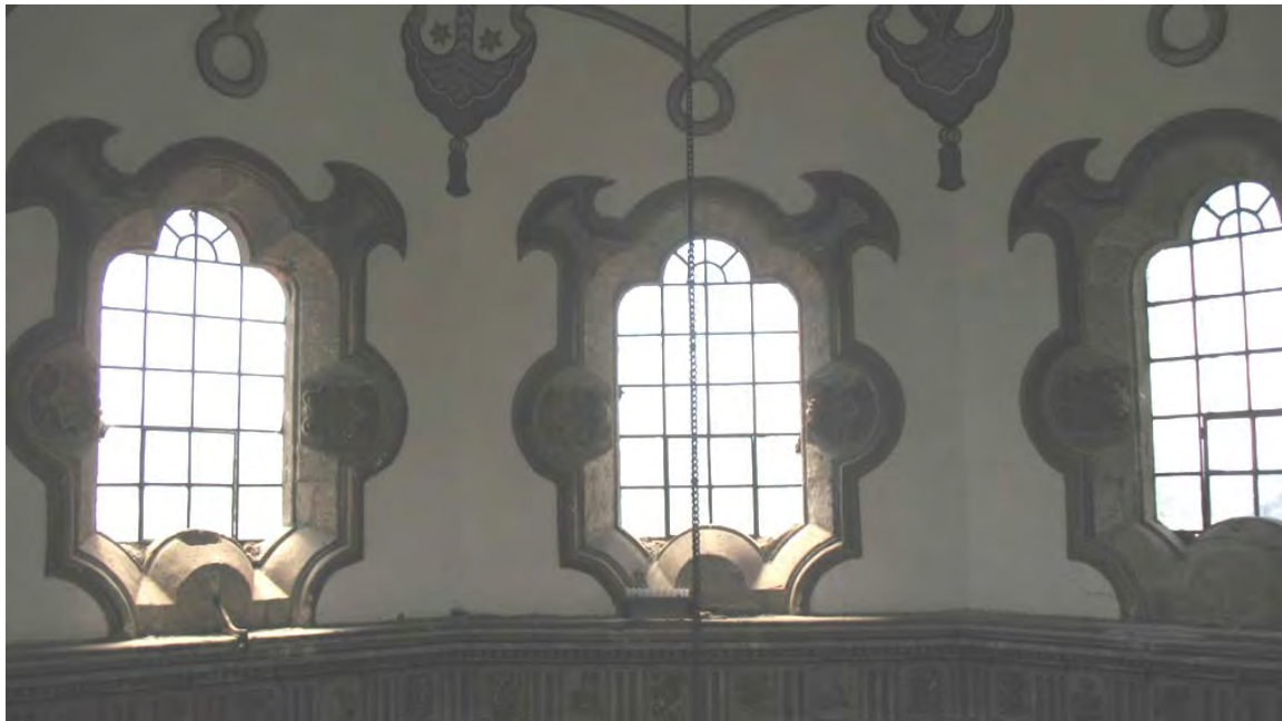
El Carmen 36 interior de las ventas ubicadas en cúpula principal.
