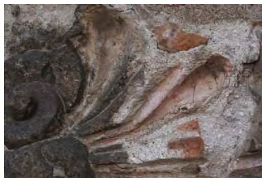
El Carmen 33 perdida de recubrimiento, humedad, flora parasita, humus. Tanto en corniseria como en las valvas decorativas.
