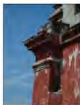
CORNISA DE PILASTRAS FABRICADA EN TABIQUE QUE PRESENTA EXISTENCIA DE FLORA Y MICROFLORA PARASITA. DESPRENDIMIENTO DE CAPA PICTORICA, ASI COMO PERDIDA DE APLANADOS.
