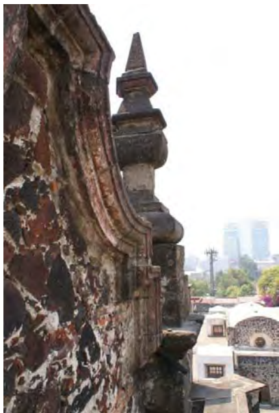
El Carmen 33 perdida de recubrimiento, humedad, flora parasita, humus. Tanto en corniseria como en las valvas decorativas.
