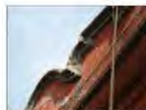
REMATE DE CANTERA QUE PRESENTA HOMOGENEA DISHOMOGENEA Y BANDA EN LAS JUNTAS.
