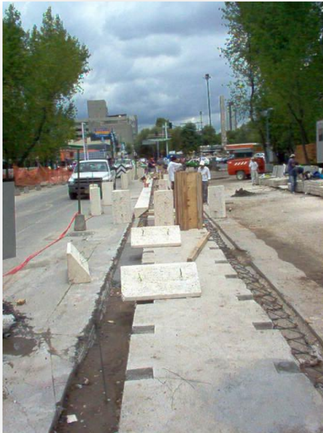
Fotografía No. 30 Detalle de piezas prefabricadas.
