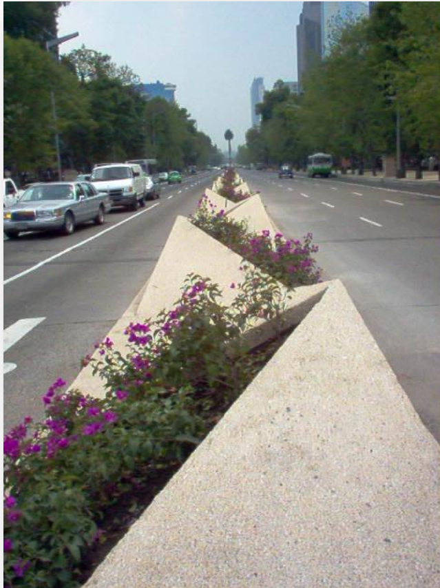
Fotografía No. 32 Camellón central de Reforma con piezas prismáticas, Tramo Lieja - Insurgentes
