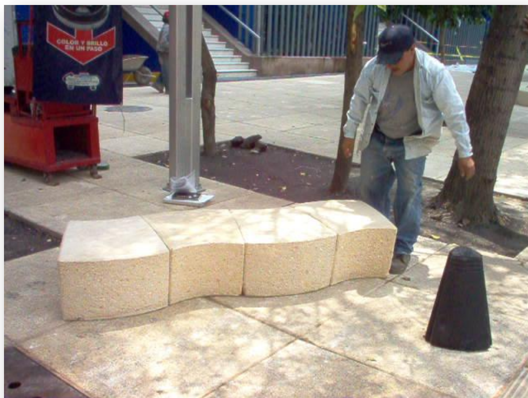
Fotografía No. 28 Colocación de bancas de concreto precolado.
