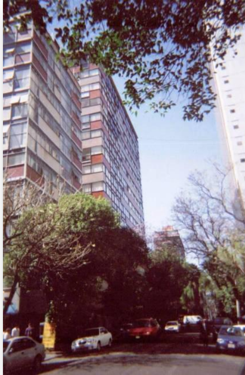
Fotografía No. 19. Condominio Varsovia No.6 esq. Paseo de la Reforma, Colonia Juárez.
