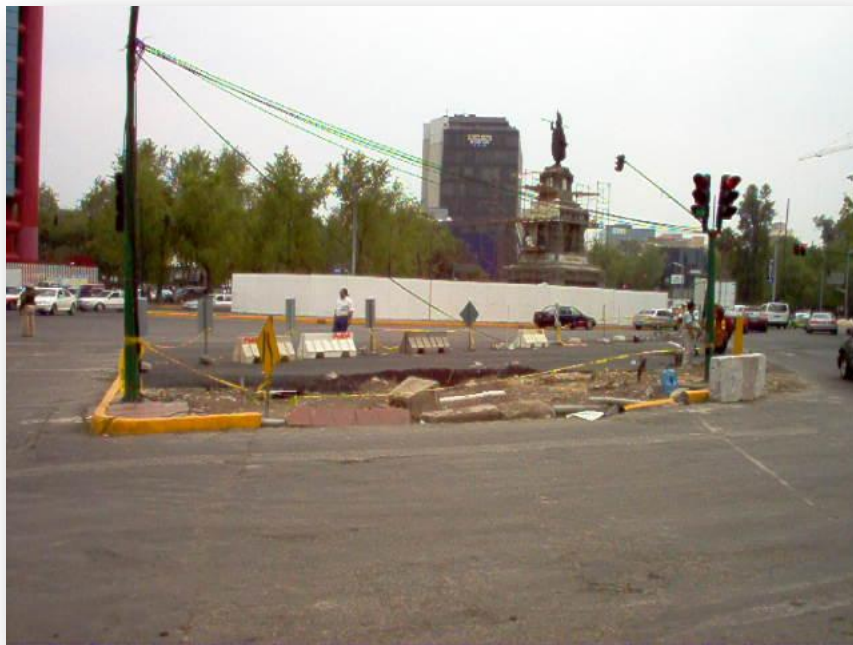
Fotografías No. 35 y 36 Trabajos de rehabilitación de la glorieta del cruce de Reforma e Insurgentes
