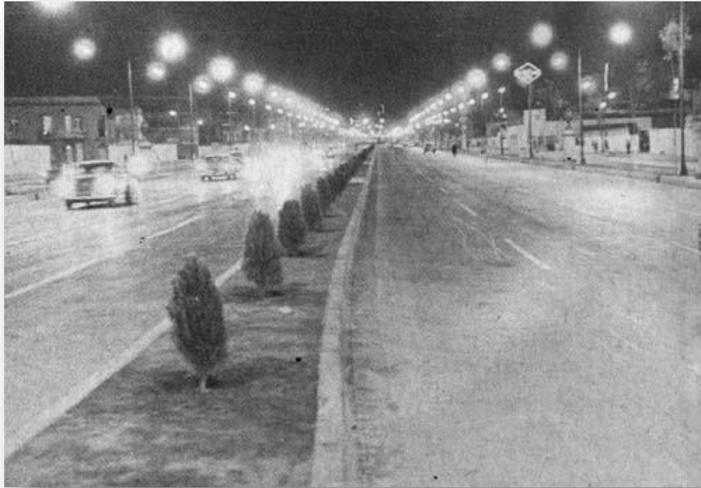
Fotografía No. 21 Vista de la ampliación hacia el Norte del Paseo de la Reforma en 1964
