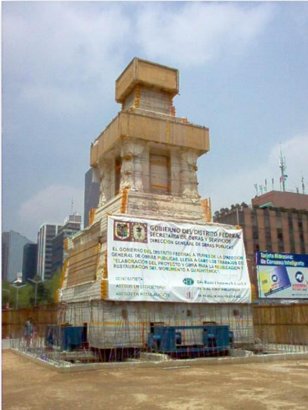
Fotografía No. 40 Preparación del basamento para su traslado
