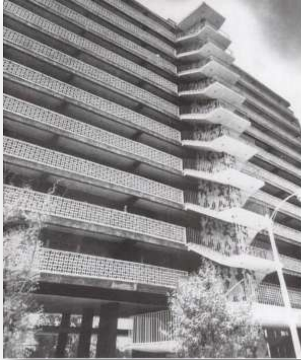
Fotografía No. 8. Vista de muros y escaleras del Centro Urbano Presidente Juárez.
