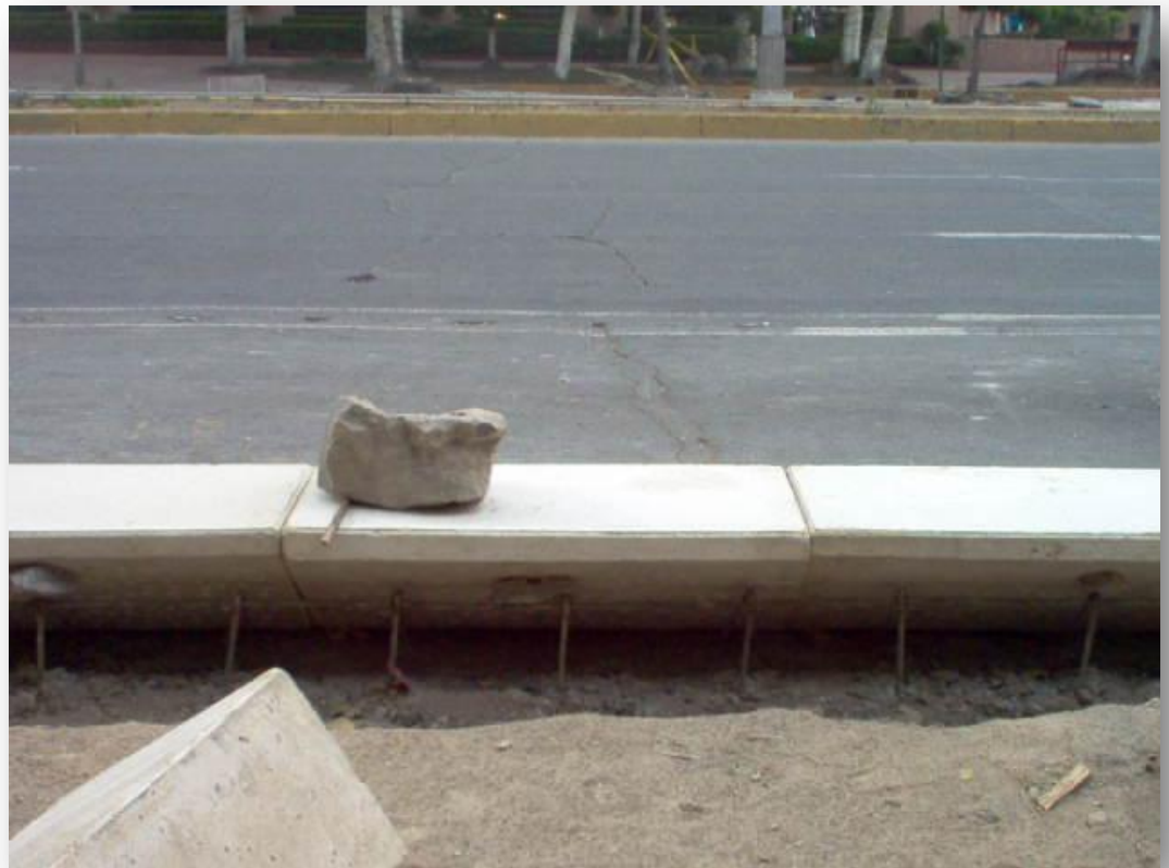
Fotografía No. 31 Detalle de construcción de guarniciones y banquetas.
