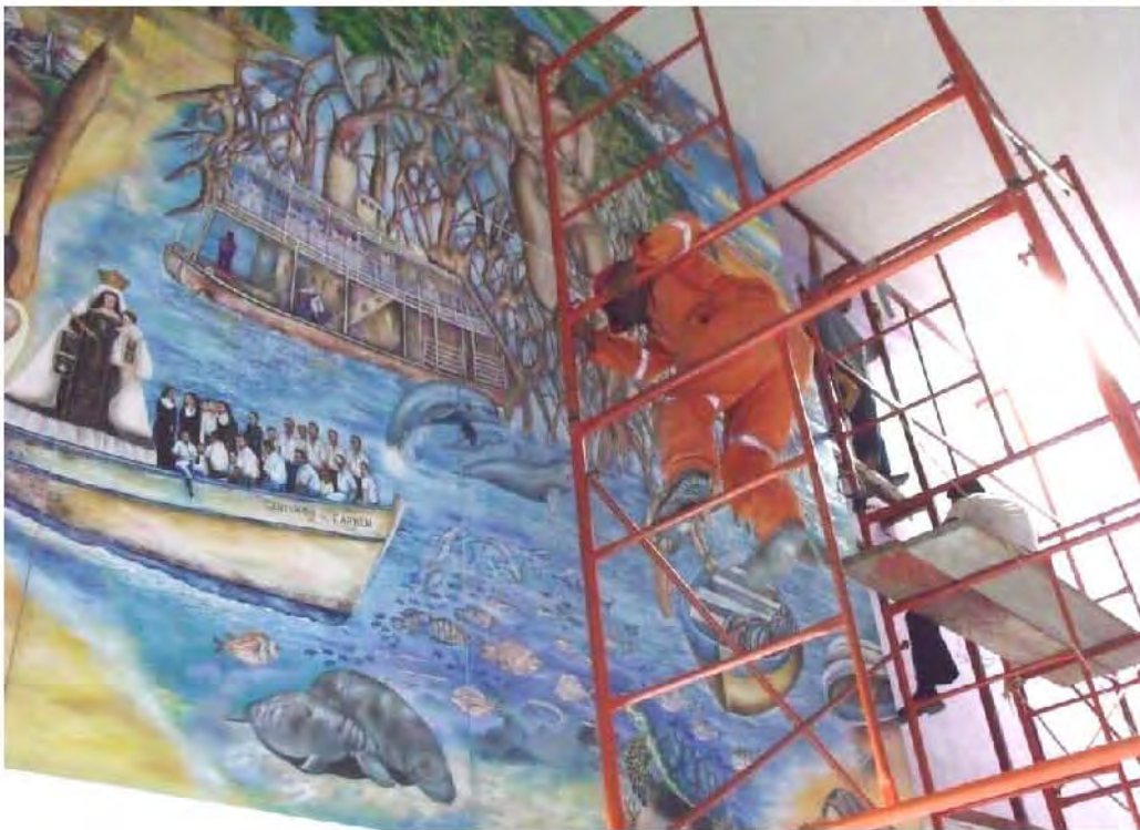
Colocación de cada bastidor de manera uniforme
