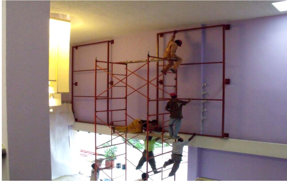
Colocación de la estructura metálica
