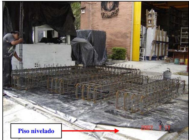
(a) Armados vigas de cimentación
