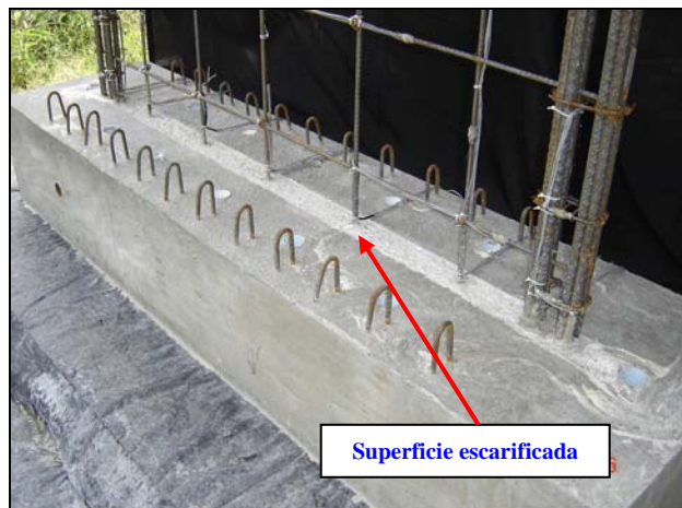
(b) Superficie de contacto con muros escarificada
