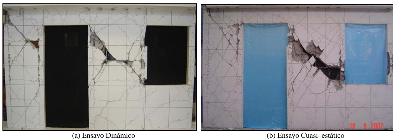
Figura 5-89. Estado final del daño en el modelo MVN100
