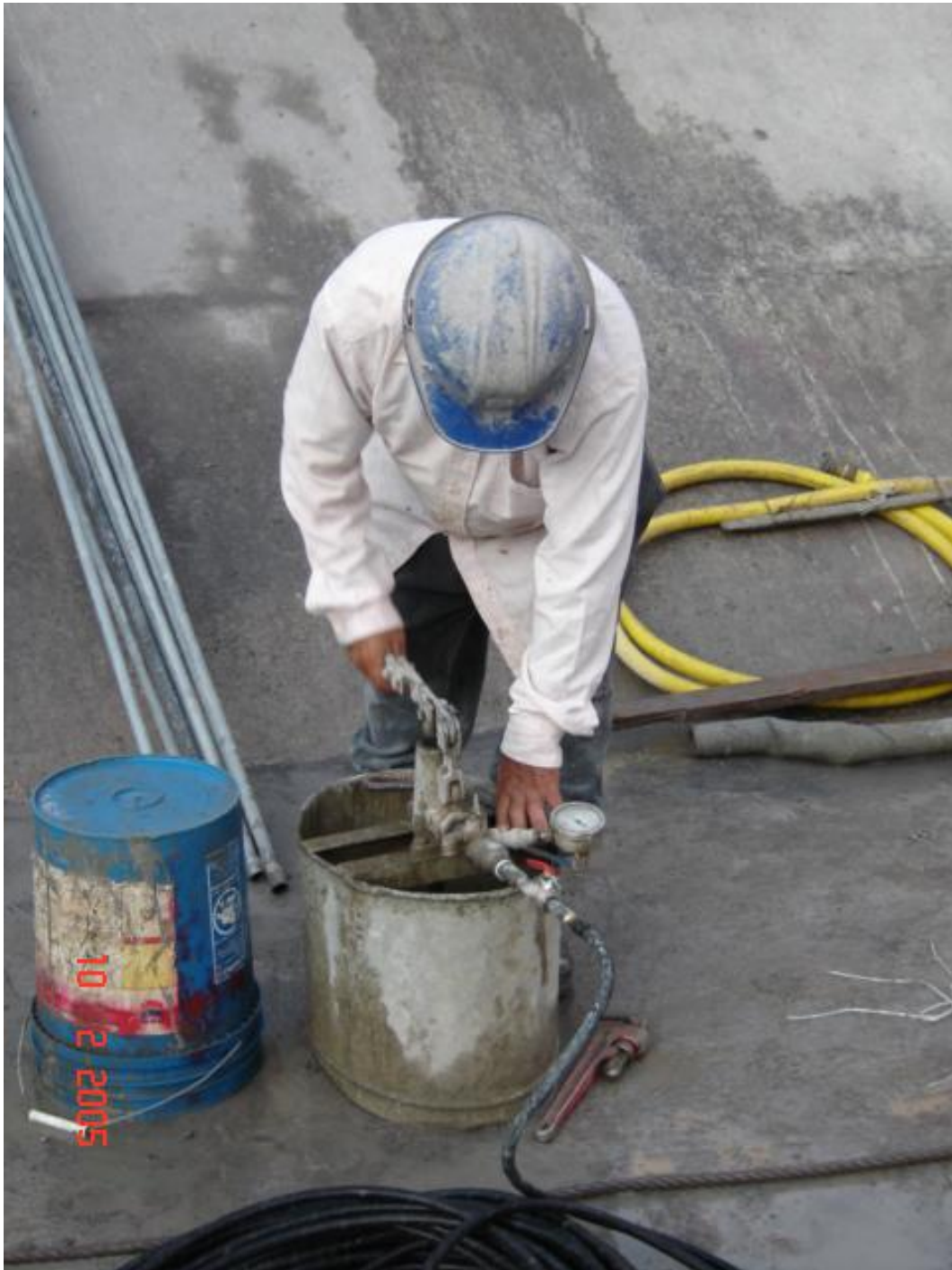
Fig. 3.4.1. Saturación previa: Ayudante general bombeando agua al barreno.
