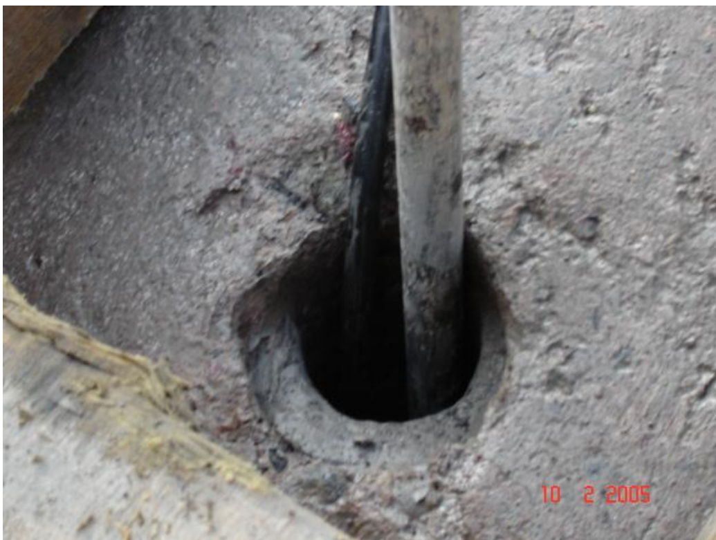
Fig 3.11.1 inyectando lechada en barreno.
