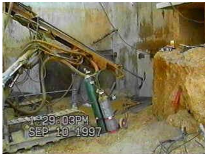
Fig. 3.2.2. Perforación para pantalla profunda
