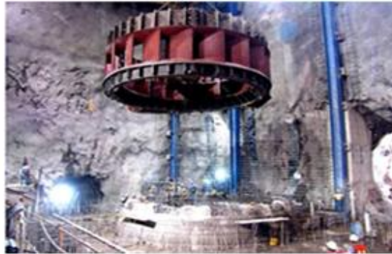
Fig. 1.1.3 turbina tipo Francis
