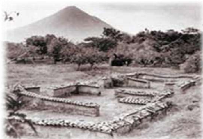
Ruinas de León Viejo, 1987. Nótese los remates aun con teja de barro. Fuente: INC
