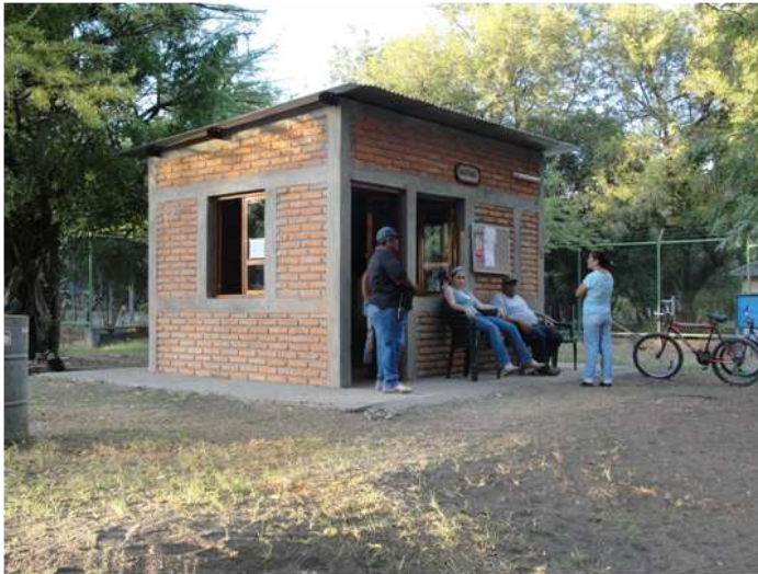
Garita de acceso vehicular
