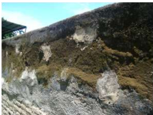
Eflorescencias y vegetales encontradas en los muros de tapial y ladrillo de la ruina No.1 Catedral Santa Ma. De la Gracia, León Viejo
