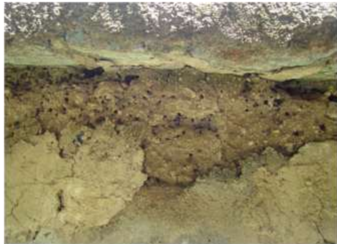
Oquedades causadas por humedad y cambios bruscos de temperatura lo que deja el material suelto y expuesto al ataque murciélagos. Izq. Ruina No.3; Arriba Ruina No. 1
