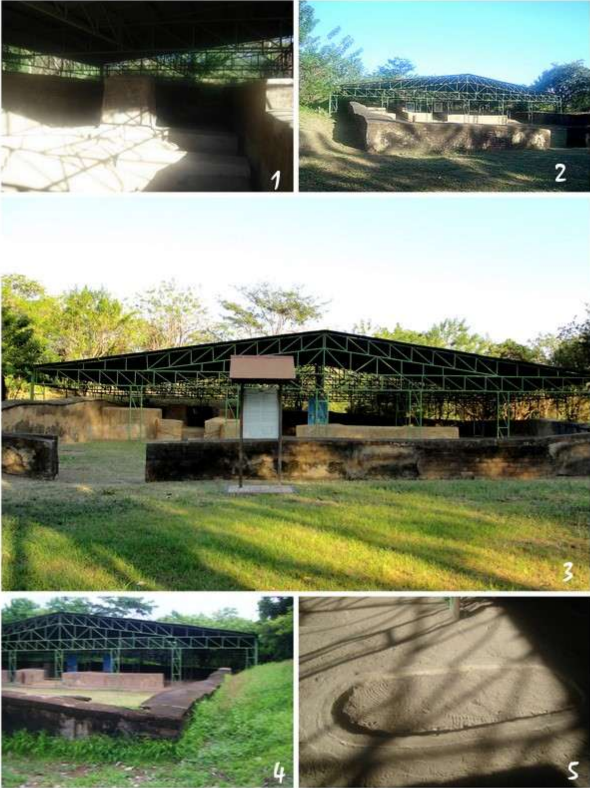
Ilustración Convento de la Merced 1. Galerías internas 2. Vista de frente (costado Este) 3. Ídem 4. Detalle de muros de tapial cediendo al empuje del terreno natural 5. Tumbas
