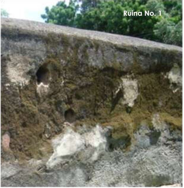
Deterioro por la presencia de murciélagos en algunas partes húmedas y cóncavas del Sitio. Foto: Pérez, P; Sampson. 2008.
