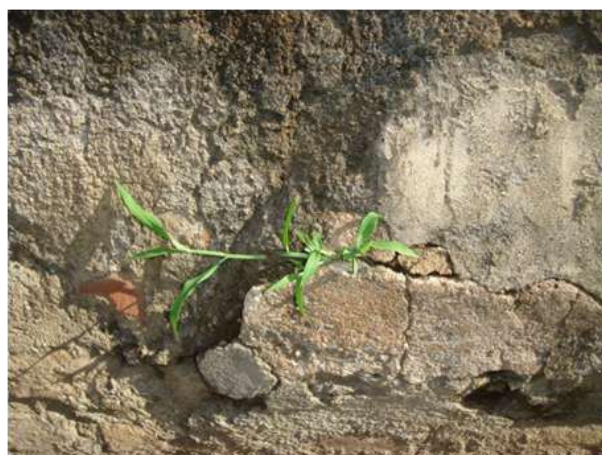
Eflorescencias y vegetales encontradas en los muros de tapial y ladrillo de la ruina No.1 Catedral Santa Ma. De la Gracia, León Viejo
