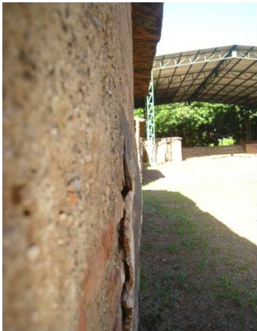
Oquedades causadas por humedad y cambios bruscos de temperatura lo que deja el material suelto y expuesto al ataque murciélagos. Izq. Ruina No.3; Arriba Ruina No. 1
