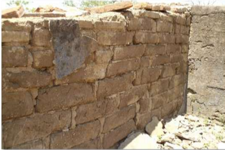
Muros de adobe de la Iglesia de la Merced en León Viejo. Nótese los escasos restos de aplanado original. Foto: M. Pérez
