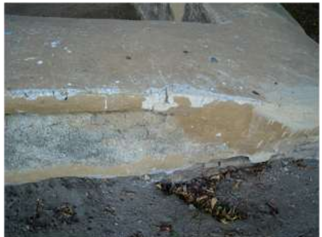
Deterioro debido a intervenciones de restauración incorrectas: fisuras, disgregación, pérdida de material original, desgaste. Foto. Pérez, M. 2008. Ruina No.1
