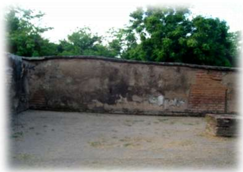
Muros de Tapial de La iglesia de Nuestra Señora de la Merced.
