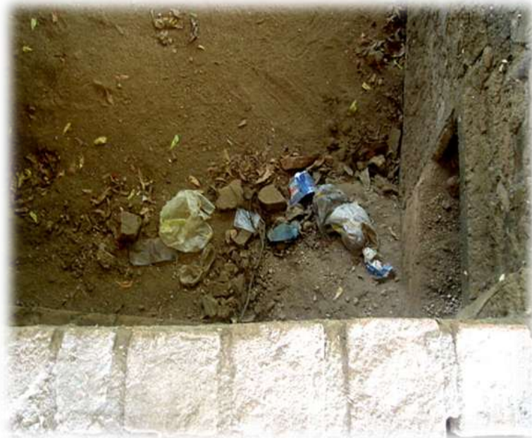
Deterioro por negligencia del visitante y falta de mantenimiento. Basura y residuos de materiales encontrados en la Ruina No.1. Foto: M. Pérez, 2007.
