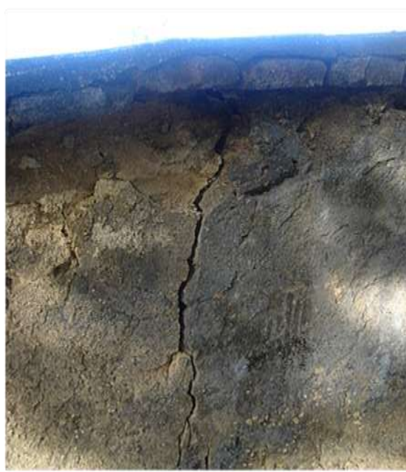
Grietas y desestabilización de piezas de ladrillo debido entre otros agentes a la presencia de sales por óxidos contaminantes. Ruina No. 3 La Fundición
