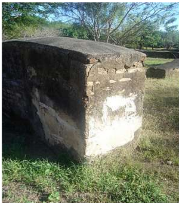
Grietas y desestabilización de piezas de ladrillo debido entre otros agentes a la presencia de sales por óxidos contaminantes. Ruina No. 3 La Fundición
