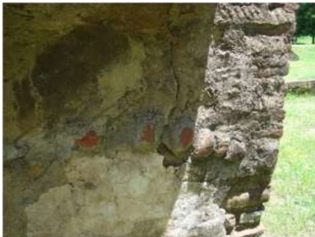
Deterioro debido a intervenciones de restauración incorrectas: fisuras, disgregación, pérdida de material original, desgaste. Foto. Pérez, M. 2008. Ruina No.1
