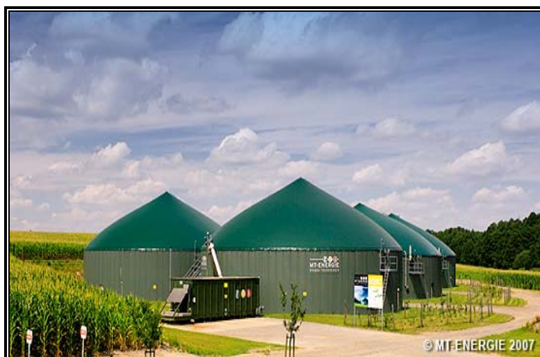
Planta de biogás. FIGURA 2.4
