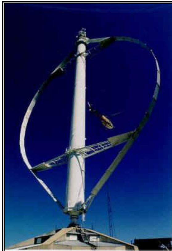
Turbina de darrieus. FIGURA. 3.7
