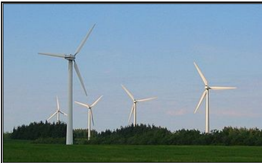
Parque eólico. FIGURA 2.14
