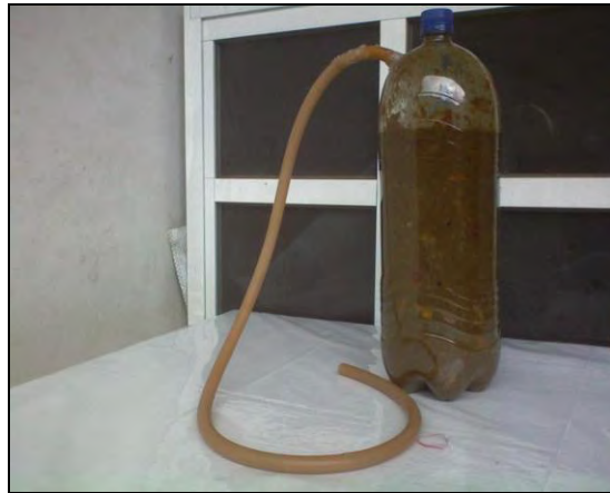
Figura 4. 7 Digestor con carga completa en el arranque.
