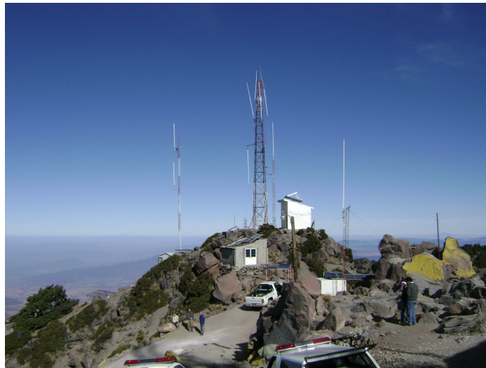
Figura 1.15: Vista de la Estación El Nevado
