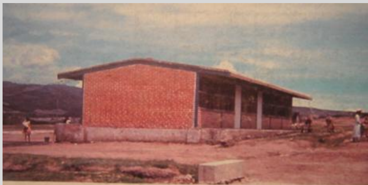
Foto 32 -Última etapa de construcción-
