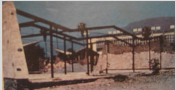
Foto 28 -Construcción de muros -
