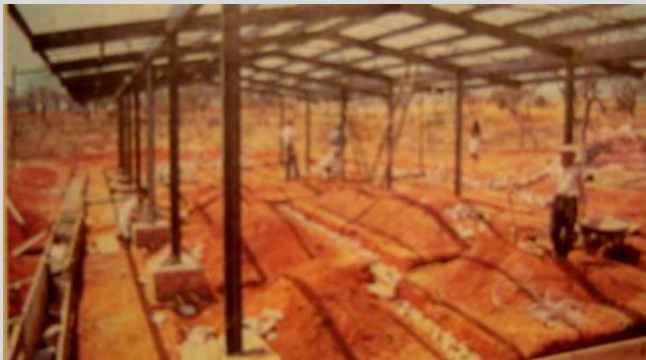
Foto 25 -Construcción de la armadura -
