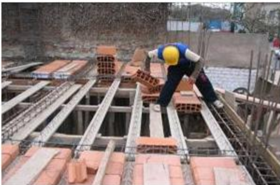
Colocación de vigueta y bovedilla
