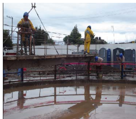
Figura 4.24 Plataforma para revisión de profundidad
