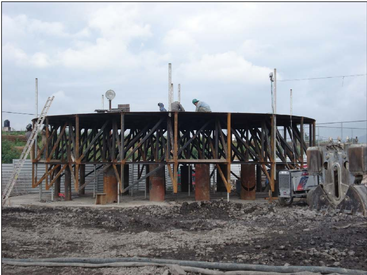
Figura A1.1 Armadura del tanque metálico
