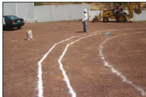
Figura 4.3.- Trazo de brocal sobre terreno.
