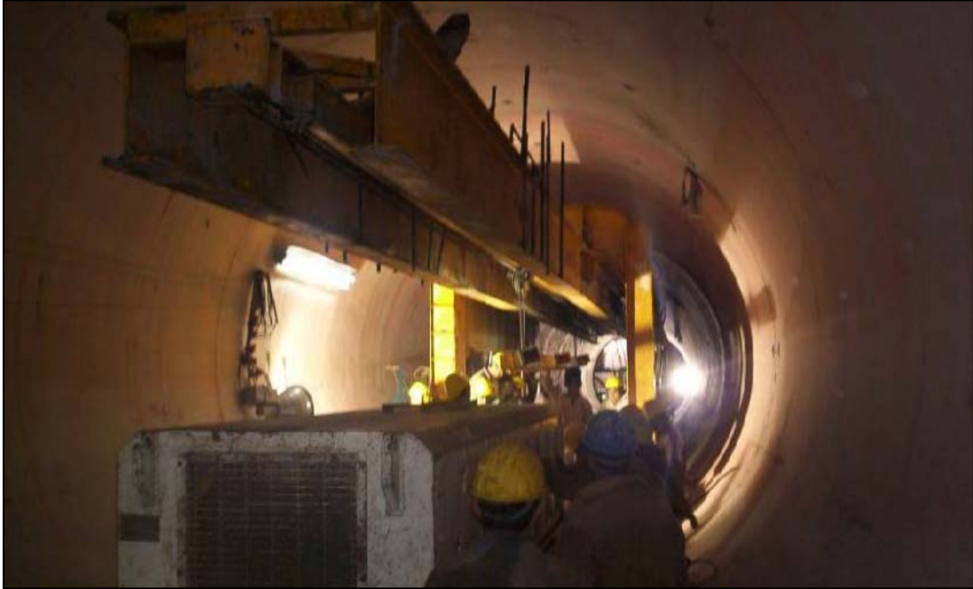
Figura A4.2. Cimbra telescópica colocada
