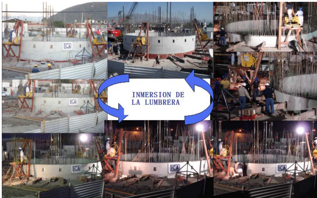
Figura 4.32 Corte de proceso de elaboración de muro e inmersión
