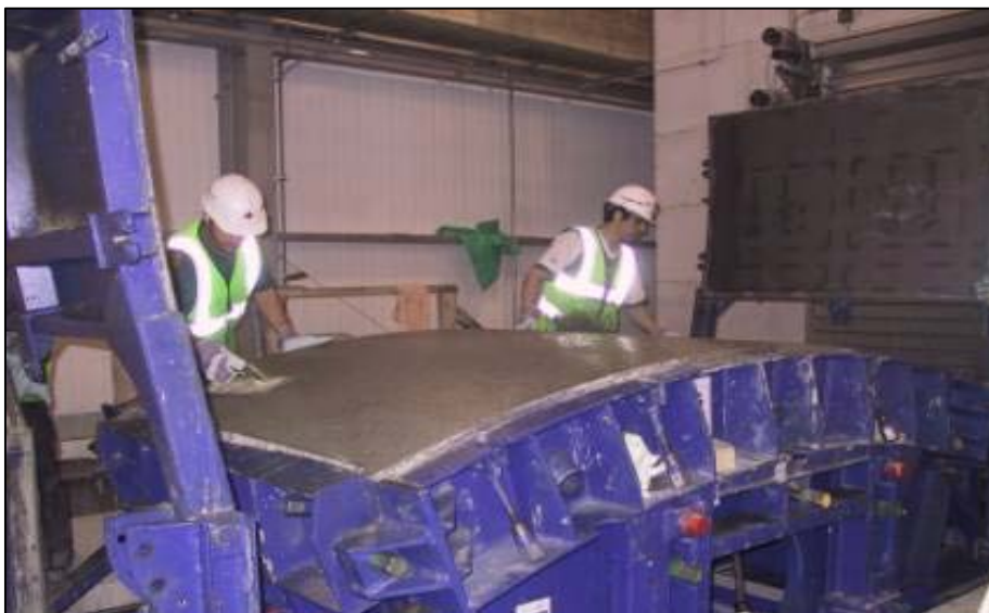
Figura A3.2. Colocación de acero en moldes
