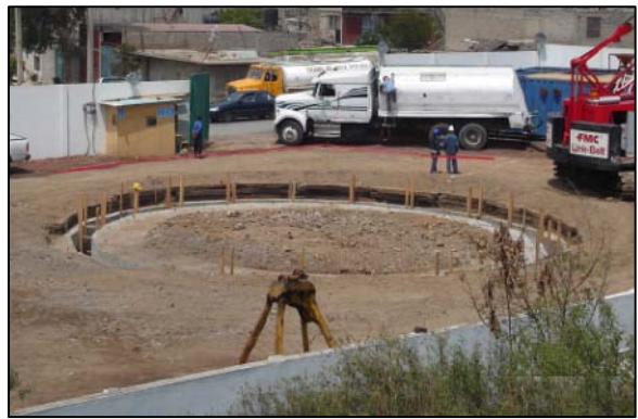
Figura 4.7 Terminado de brocales.
