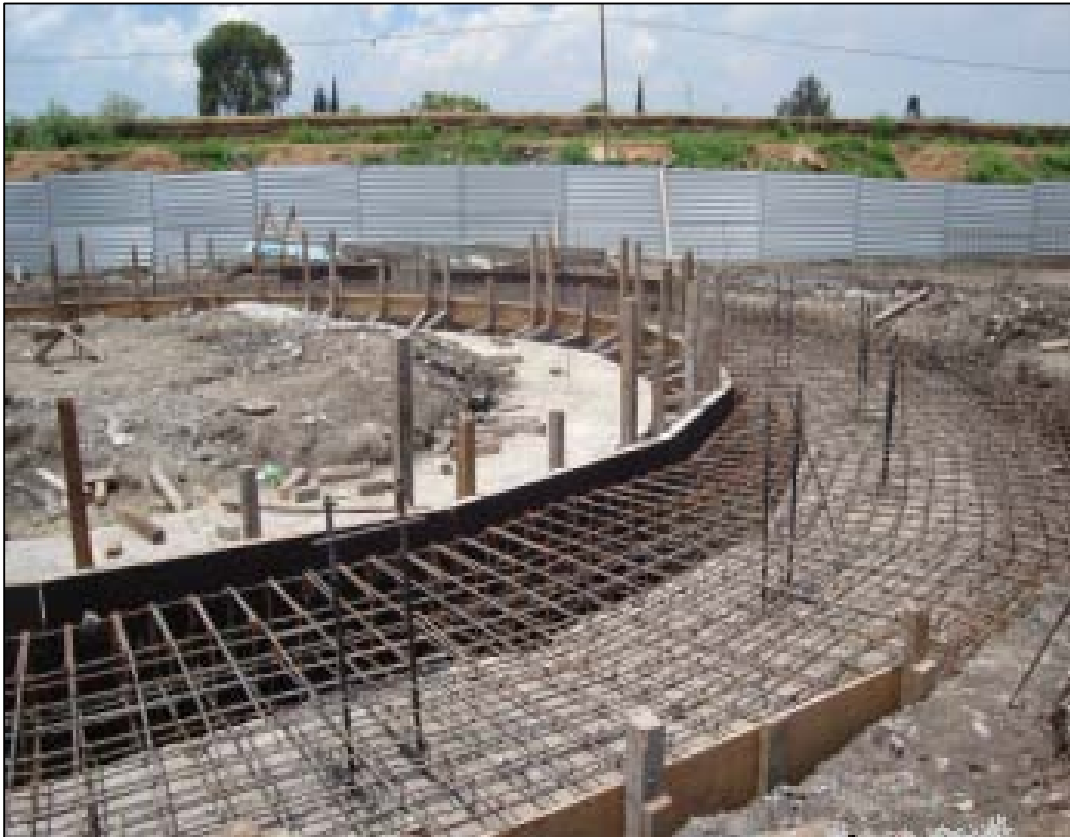
Figura 4.17 Armado del brocal definitivo
