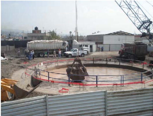
Figura 4.21 Extracción con almeja
