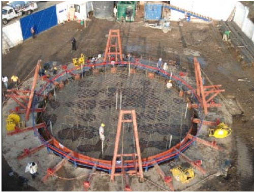
Figura 4.29 Armado losa de fondo.
