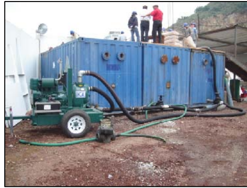
Figura 4.12 Bombeo de lodos.
