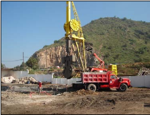
Figura 4.9 Excavación en el tablero.
