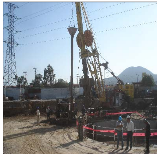
Figura 4.16 Colocación de mortero con tubería tremie
