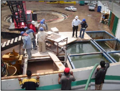
Figura 4.11 Preparación de lodo fraguante.
