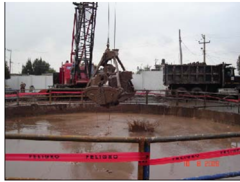
Figura 4.20 Extracción de material con almeja
