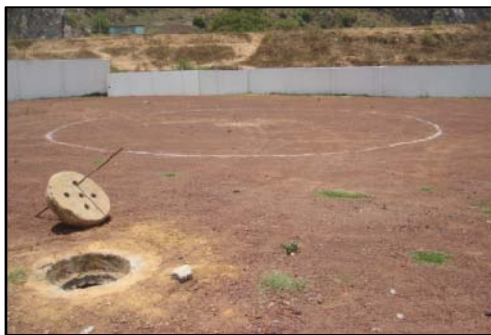
Figura 4.2.- Adecuación de terreno para área de trabajo.
