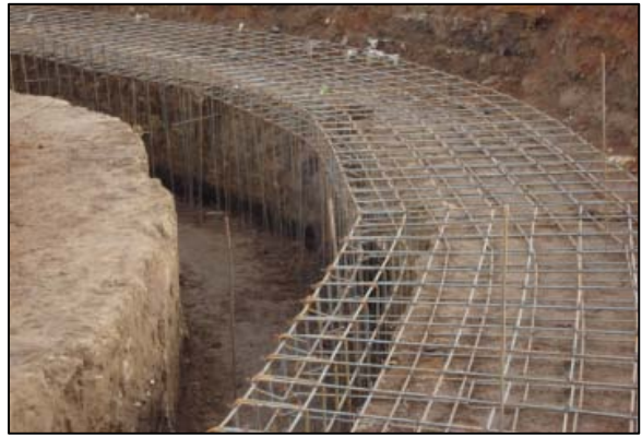
Figura 4.5. Armado de Brocal exterior provisional.
