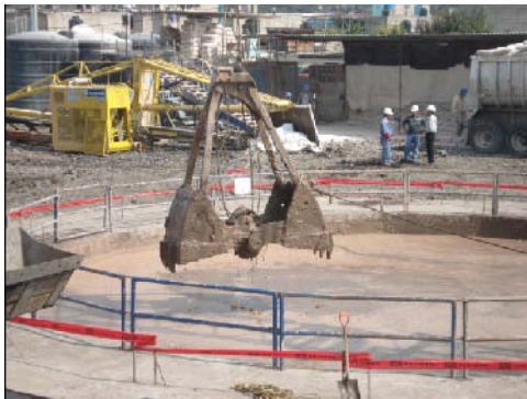
Figura 4.19 Extracción de material con almeja
