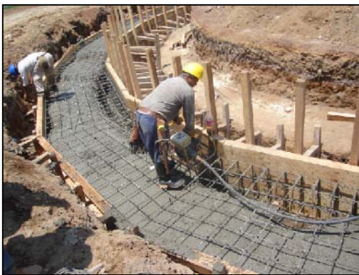
Figura 4.6. Colocación de concreto.
