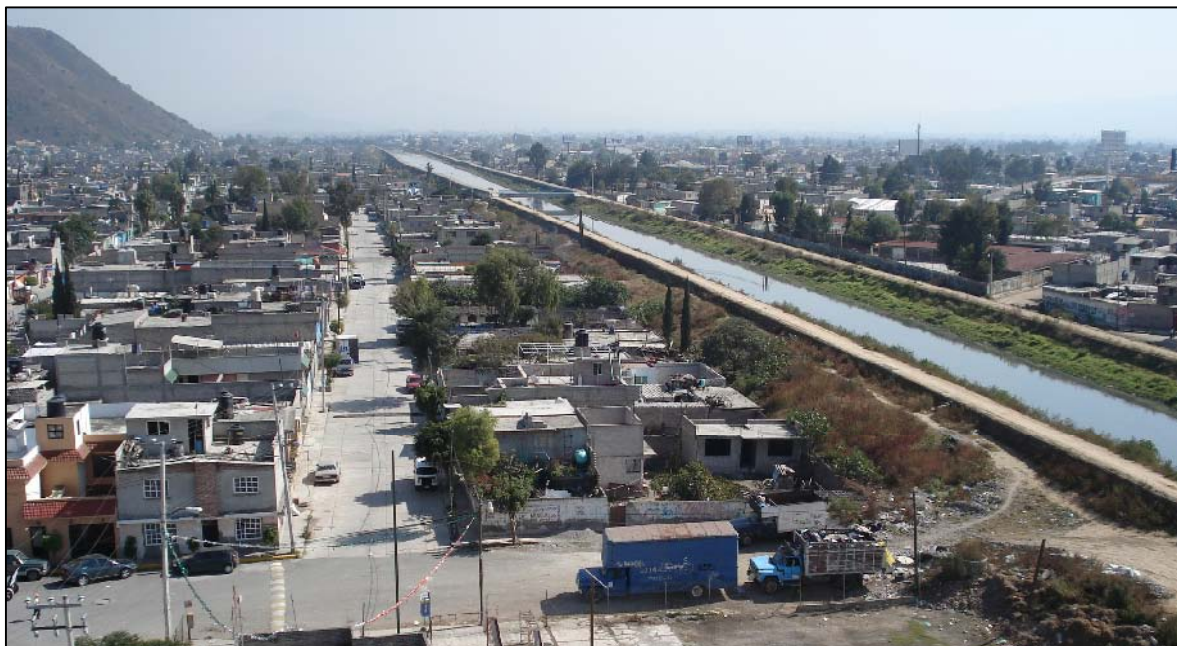
Figura 1.1.- Fotografía del canal a cielo abierto
