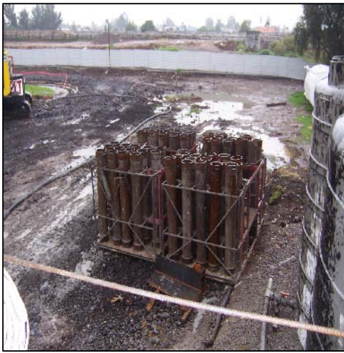
Figura 4.15 Tubería tremie
