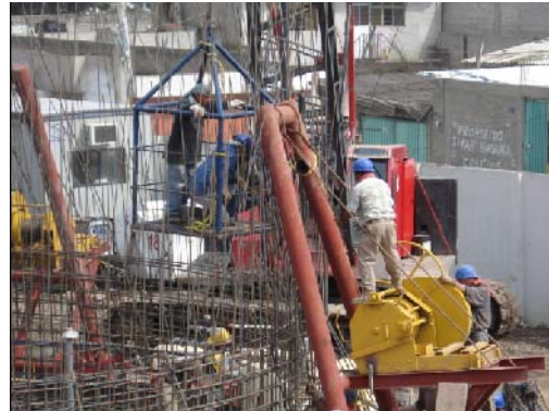
Figura 4.30 Armado de 1º muro de lumbrera.
