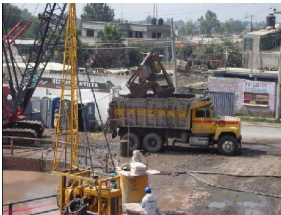
Figura 4.23 Descarga de almeja en camiones de volteo
