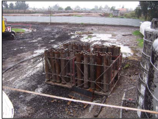
Figura 3.8.- Tubería Tremie
