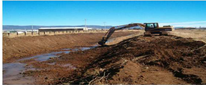
Excavación para zanja de riego .
