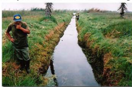
Zanja de riego .
