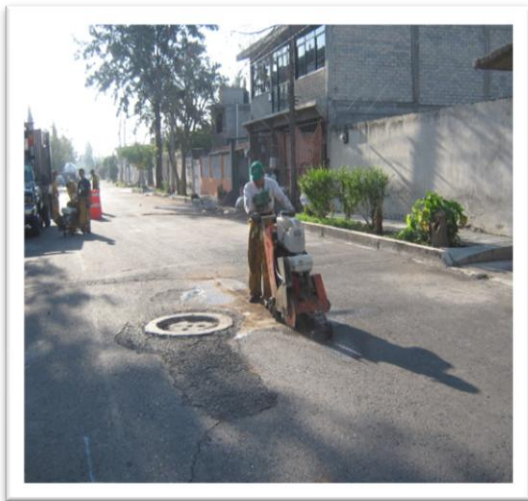
(Fig. 3.3.4) CORTE CON SIERRA MECÁNICA.
