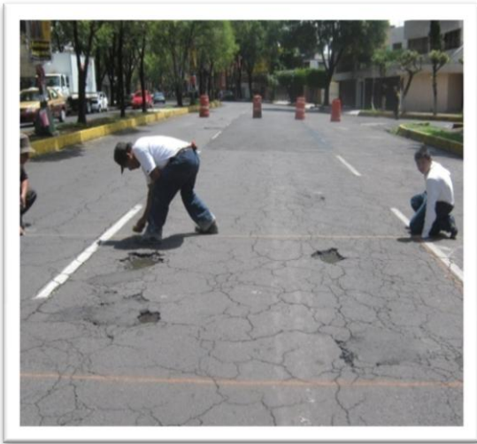
(Fig. 3.3.3) TRAZO PARA REPARACIÓN.
