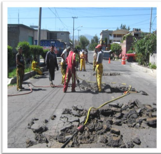
(Fig. 3.3.5) DEMOLICIÓN CON COMPRESOR NEUMÁTICO.
