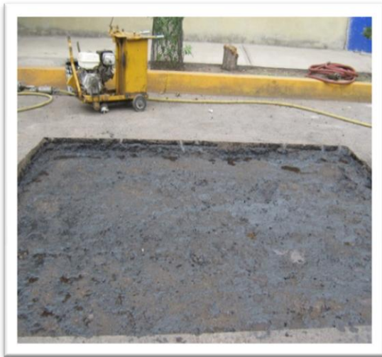
(Fig. 3.3.8) RIEGO DE LIGA A RAZÓN DE 1 LITRO POR M 2 .
