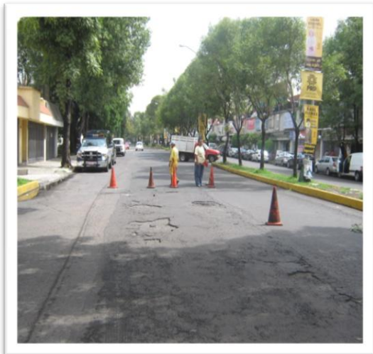
(Fig. 3.3.2) SEÑALIZACIÓN CON CONOS Y TRAFITAMBOS.
