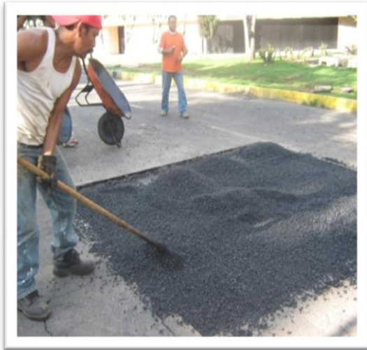
(Fig. 3.3.9) RELLENO DE ASFALTO 2ª CAPA 5 CMS.
