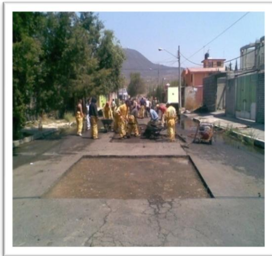
(Fig. 3.3.7) PERFILADO Y LIMPIEZA DE LA CAJA.
