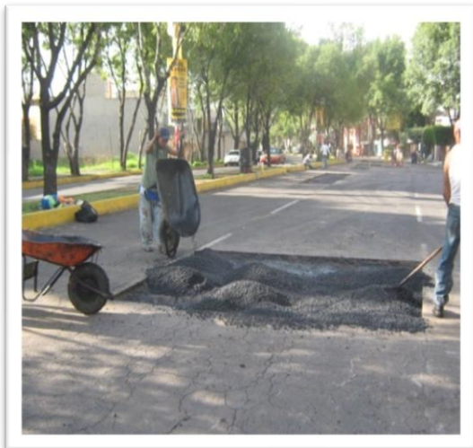
(Fig. 3.3.9) RELLENO DE ASFALTO 1 a CAPA 5 CMS.
