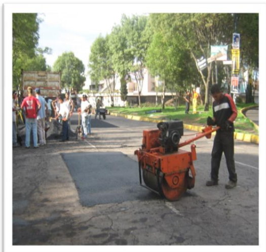
(Fig. 3.3.10) COMPACTACIÓN CON RODILLO VIBRATORIO MANUAL.
