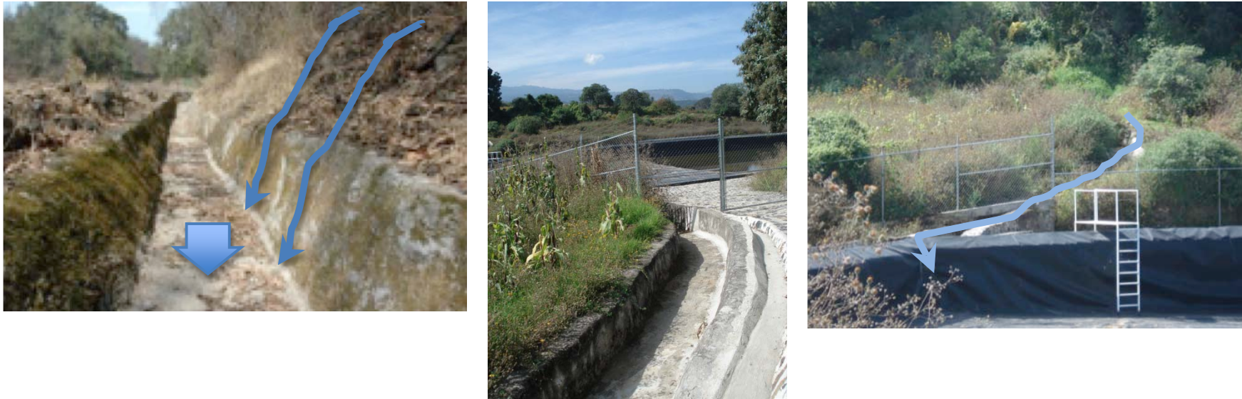
Figura 49. Canales Principales, nótese cómo el canal está adecuado para recibir naturalmente los escurrimientos de agua pluvial.
