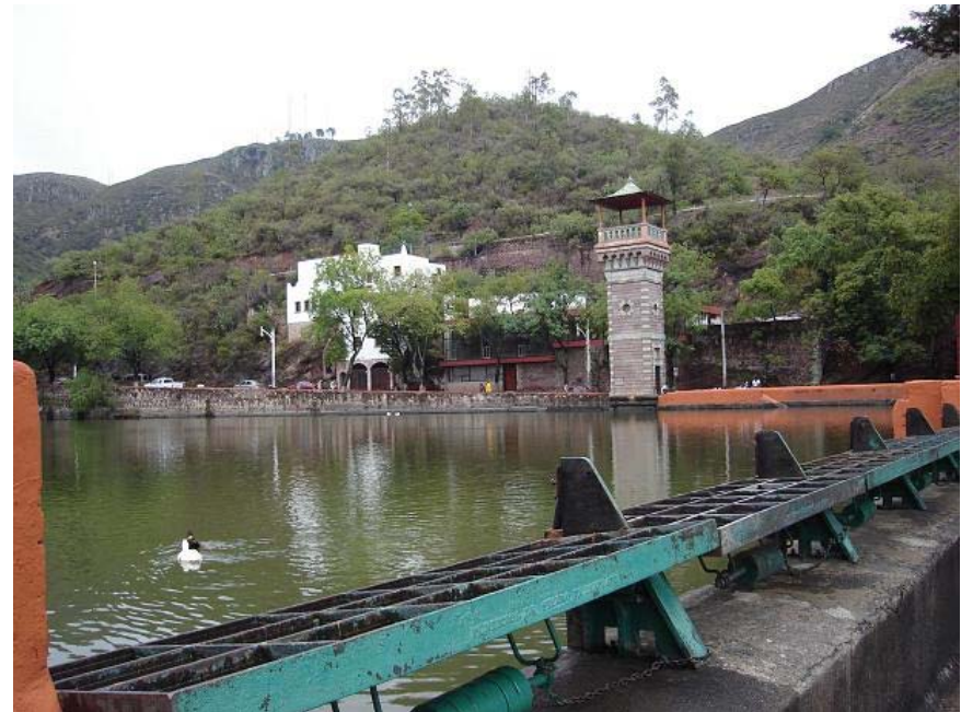
Figura 62. Vista actual de la presa de la Olla, Guanajuato, Gto.
