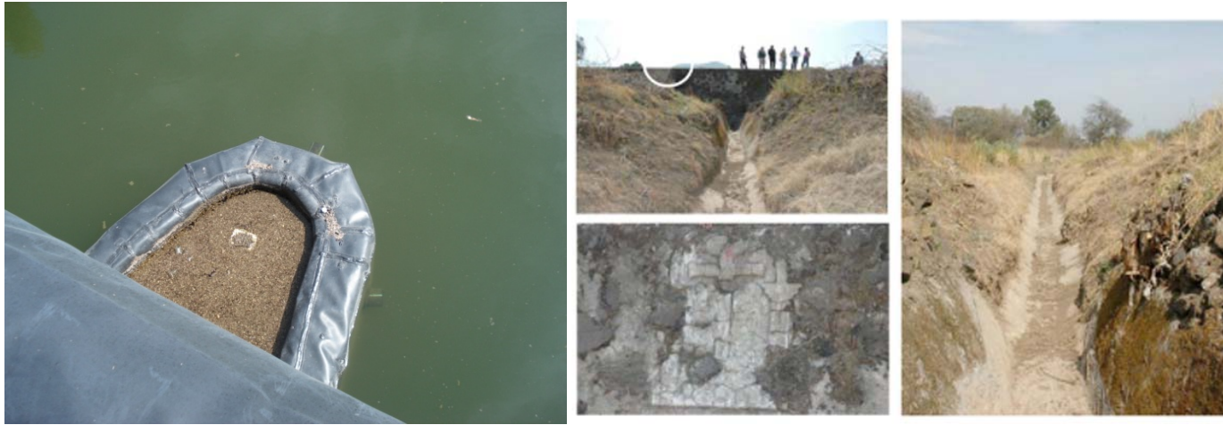
Figura 51. Compuerta, Toma de agua y canal.
