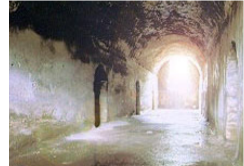
Figura 11. Cisterna de la Salle, ejemplo de cisterna de cámaras abovedadas sin pilares
