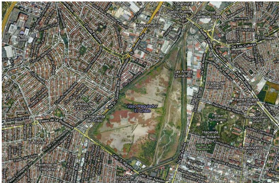
Figura 66. Vista aérea del Vaso Regulador el Cristo en Naucalpan.
