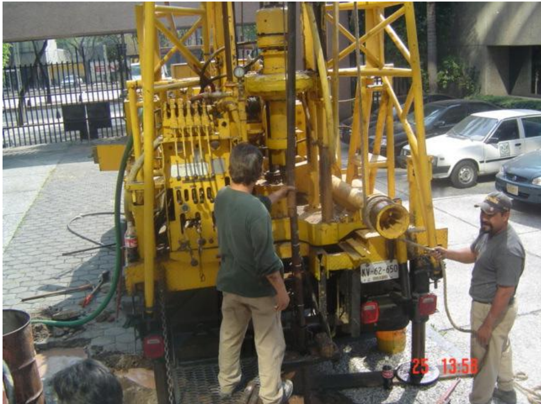
Equipo de perforación utilizado para el estudio de mecánica de suelos
