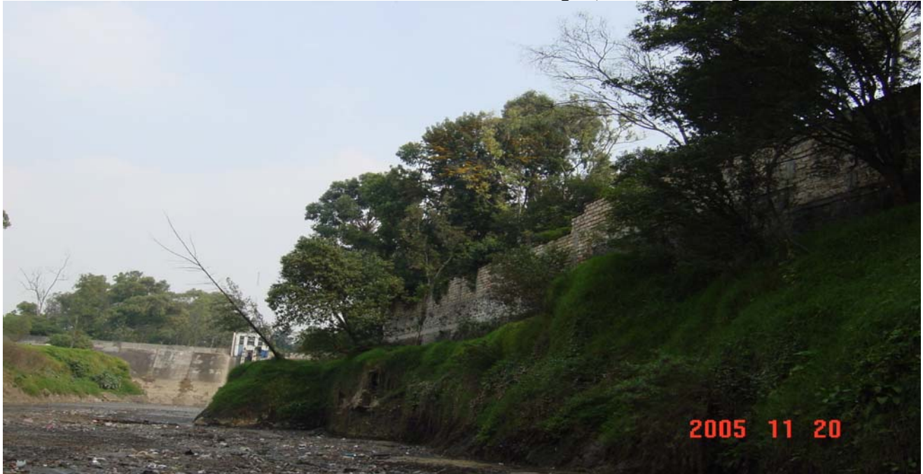
Foto No.10.7.- Presa Texcalatlaco. Muros de Tabique, Margen Izquierda.
