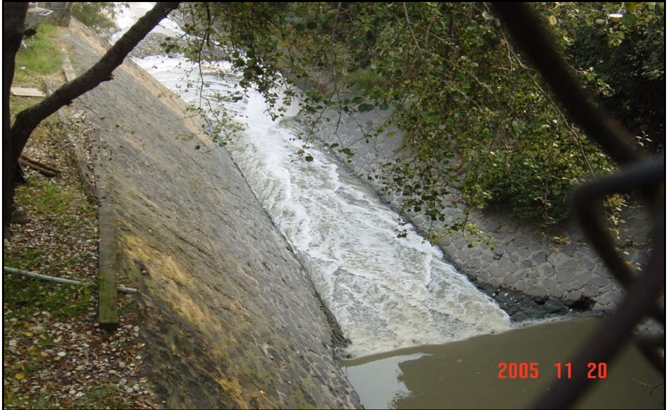
Fotografía No.9.3.-Descarga de Colector Luis Cabrera a Presa Anzaldo.
