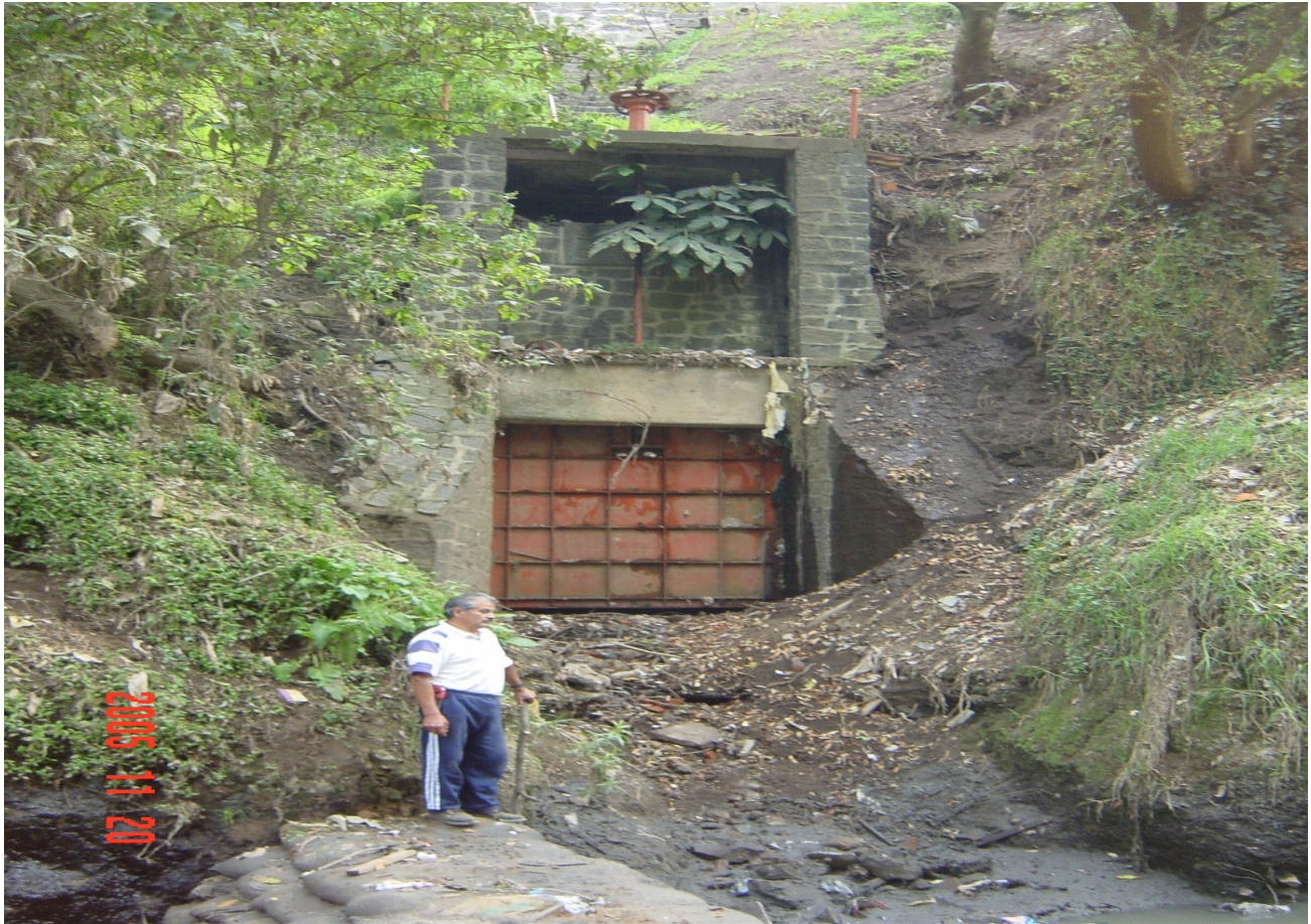
Foto No.10.5.-Túnel de alivio en la Presa Texcalatlaco.
