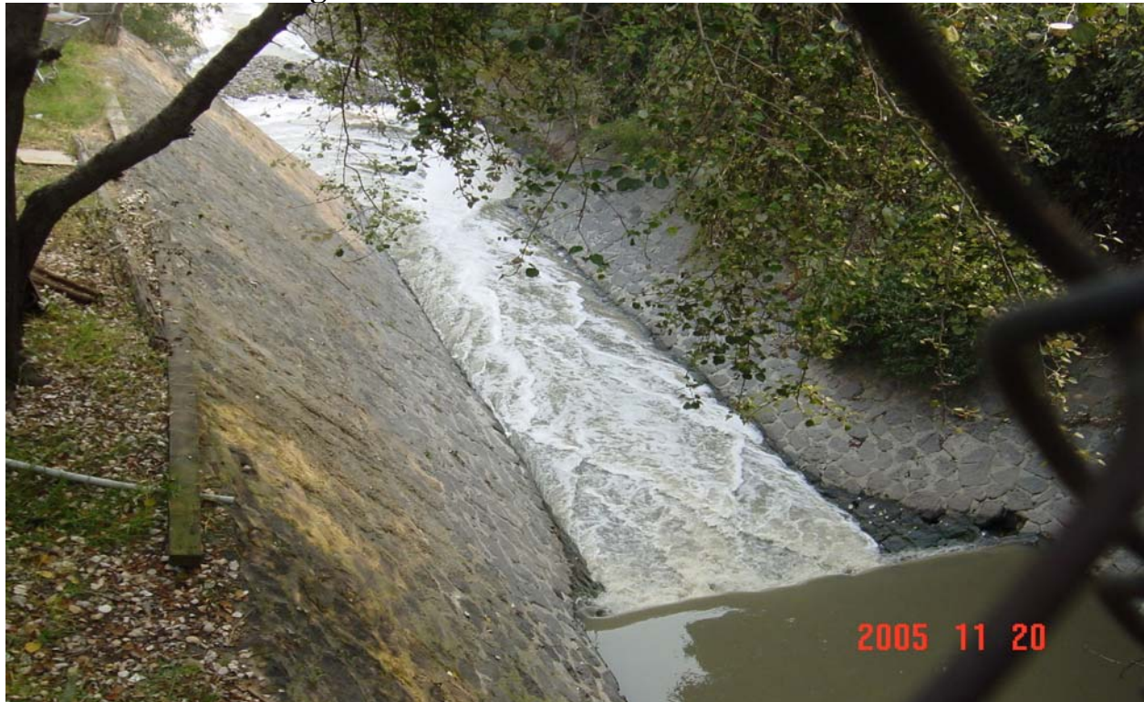
Foto No.10.6.-Descarga del Colector Luis Cabrera en la Presa de Anzaldo.
