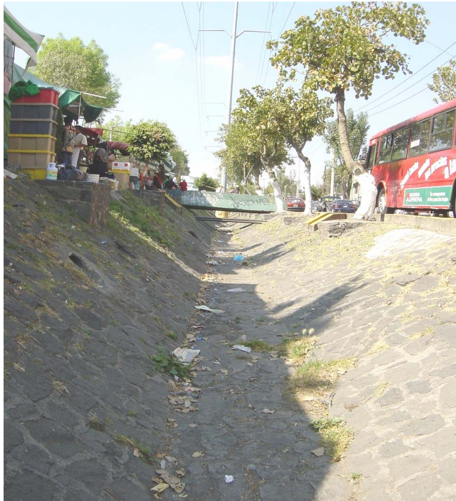
Foto No.13.2.-Colector de Tormentas a Cielo Abierto.
