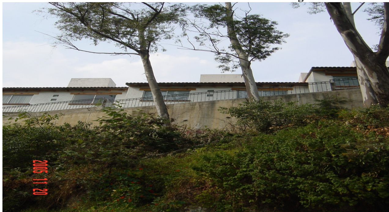
Foto No.10.8.- Presa Texcalatlaco Muros de Contención Margen Derecha.
