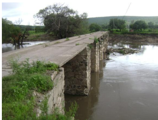
FOTO 6. PUENTE QUE DIVIDE SANTA FE DEL RIO (MICHOACAN) CON SAN MARCOS (GUANAJUATO)
