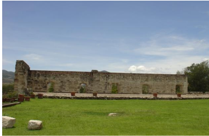
Imagen en la parte posterior de la zona de la hospedería en Yanhuatlán. 134
