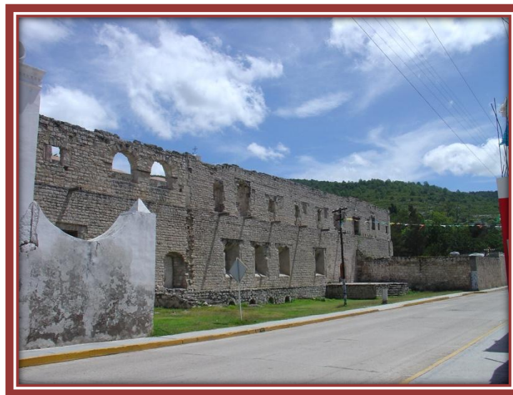
Fachada de la zona sur, correspondiente al refectorio en Teposcolula. 195
