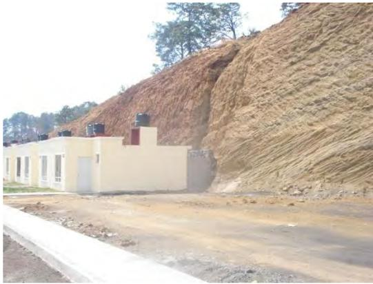
Foto N° 1 fuente propia. (Corte del cerro, y construcciones a un lado del corte.)
