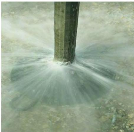
**Figura 4.20. Boquilla para el Jetting, muestra la velocidad de flujo y la dirección en la cual se encuentran los orificios.**
