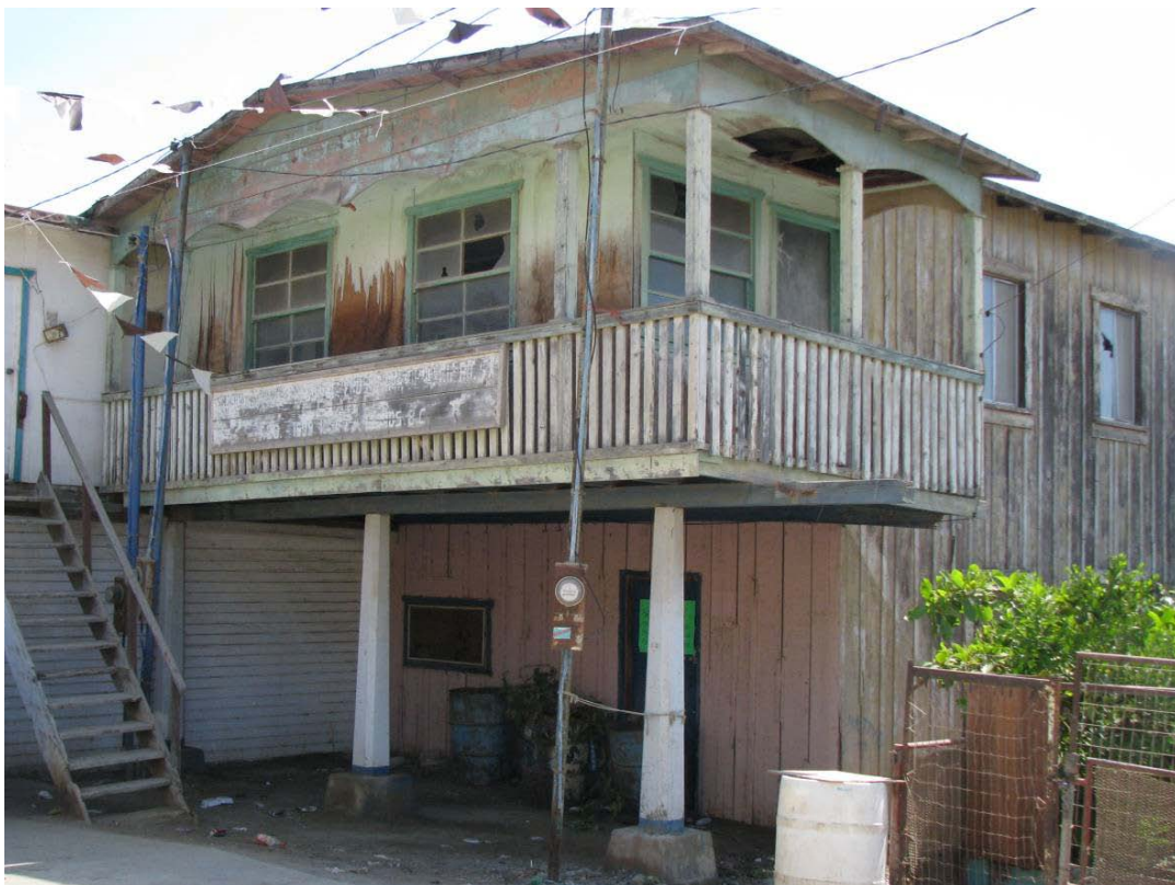
Foto 8. Entre las construcciones en deterioro que siguen en pie se encuentra la “casa del sindicato” de antigua la pesquera.
