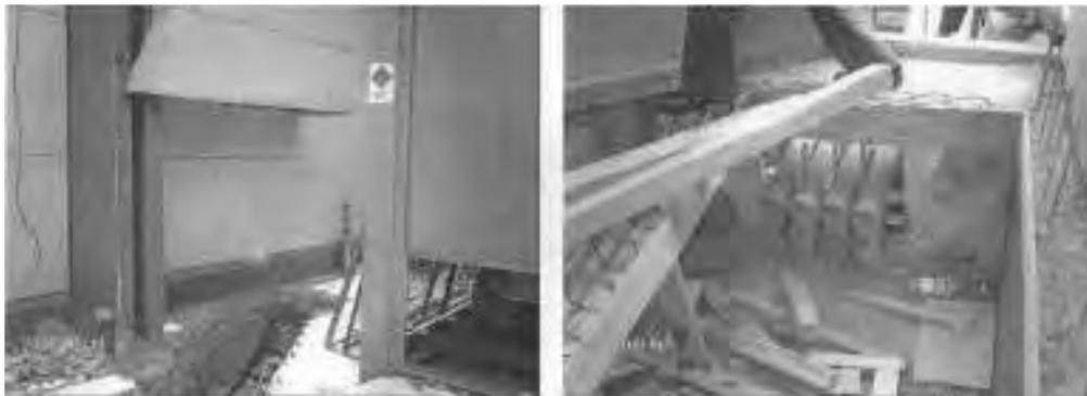
*Figura 6.4.* Maniobras para canalización del cableado XLP de media tensión de la nueva subestación.
