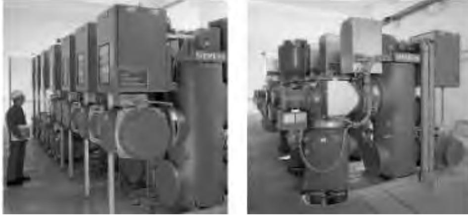
*Figura 3.13. Vista en campo de la celda seccionadora 8DN8 de Siemens.*
