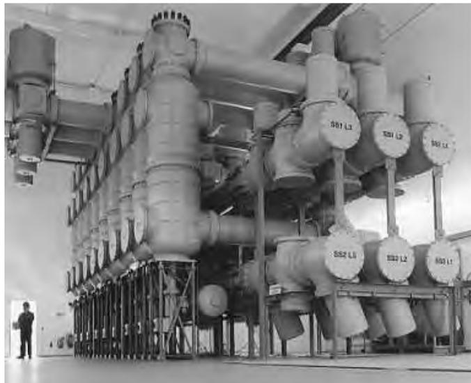
*Figura 3.1.* Subestación AEG aislada en SF<sub>6</sub> de 420 kV.
