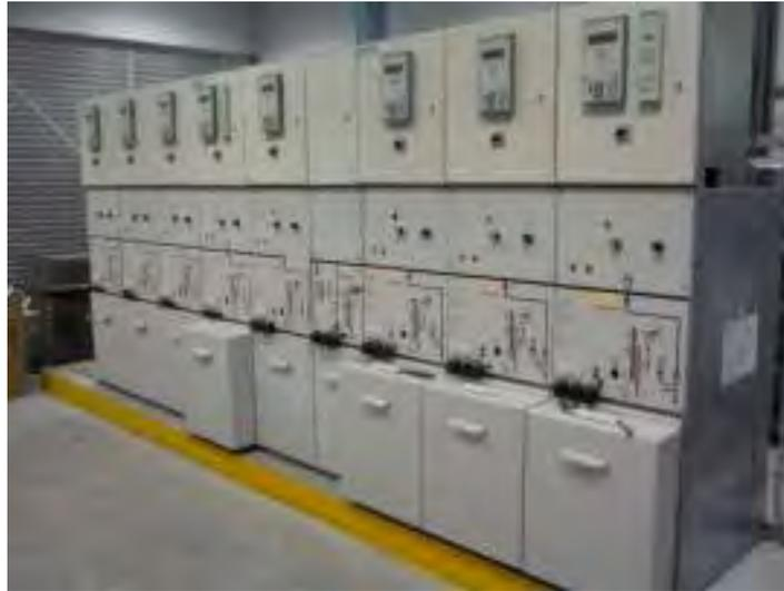
*Figura 6.10.* Pruebas finales del sistema en anillo.
