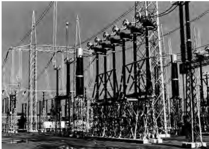
*Figura 3.8.* Vista de una subestación de alto voltaje aislada en aire (AIS) en la cual se puede apreciar sus dimensiones y la forma en la que está expuesta a la intemperie.
