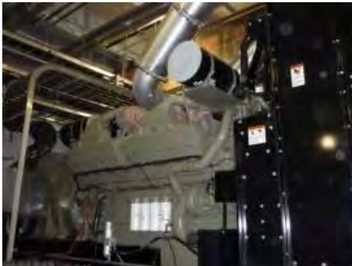
*Figura 6.11.* Pruebas de planta de emergencia de 2000 kW.
