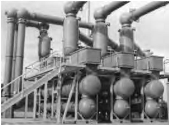
*Figura 3.2* Primera Subestación GIS de 800 kV (Sistema de American Electric Power (USA)).
