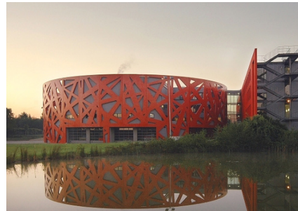
Imagen 30.- Estación de Bomberos Cologne fire Brigade hp, Germany 15
