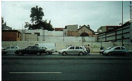
Vista B-Imagen 51: Vista frontal del predio que colinda hacia el este, desde la acera frontal con la Av. de los Insurgentes,
