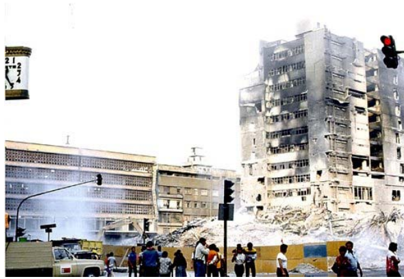
Imagen 3.- Este terremoto ocurrió en México D.F. en 1985, fue de 8.1 grados en la escala de Richter y provocó la muerte de miles de personas. La zona que más afectada fue el D.F., en la imagen se observa el derrumbe del hotel Regis que estuvo ubicado en la avenida Juárez. 2
