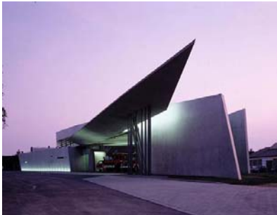
Imagen 29.-Estación de Bomberos Vitra fire Station, Germany
