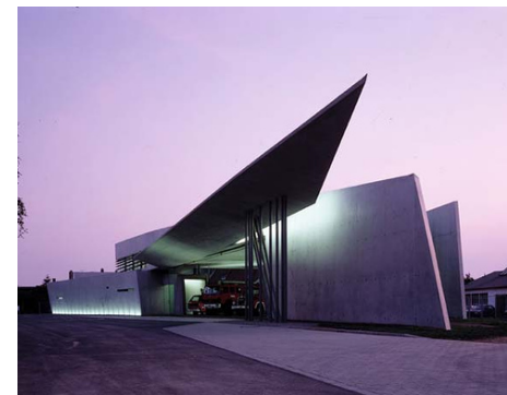
Imagen 13.- Estación de Bomberos Vitra fire station, Germany 19
