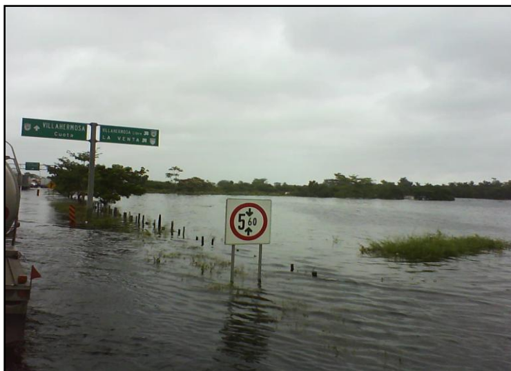
Figura 1.28 La infraestructura carretera se vio gravemente afectada además de dejar incomunicada a la población. (Diversas páginas de internet, 2009)
