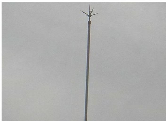
Figura 3.32 Punta pararrayos tripolar.
