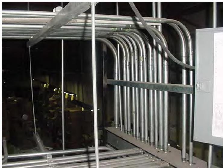
Figura 2.13 Tuberías de circuitos derivados.
