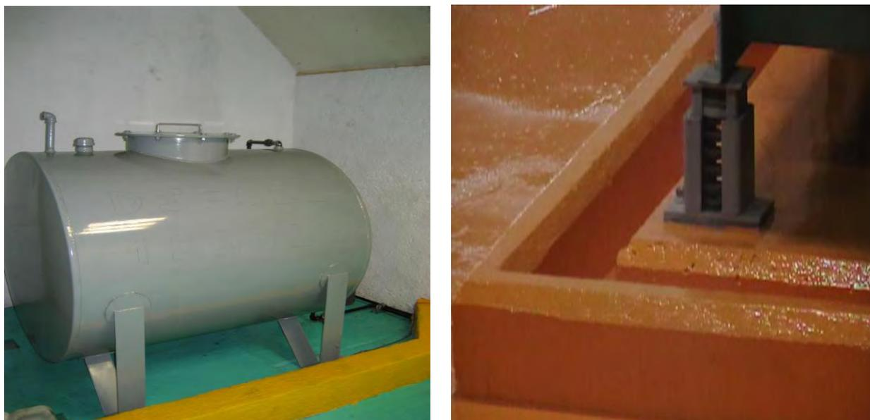
Figura 2.23 Sardinel para contenedor de diesel y sardinel para planta de emergencia con base tanque.
