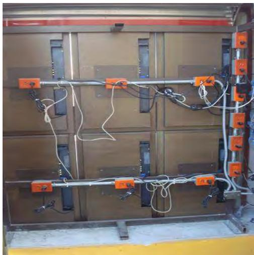
Figura 2.8 Buena distribución, mal cableado.
