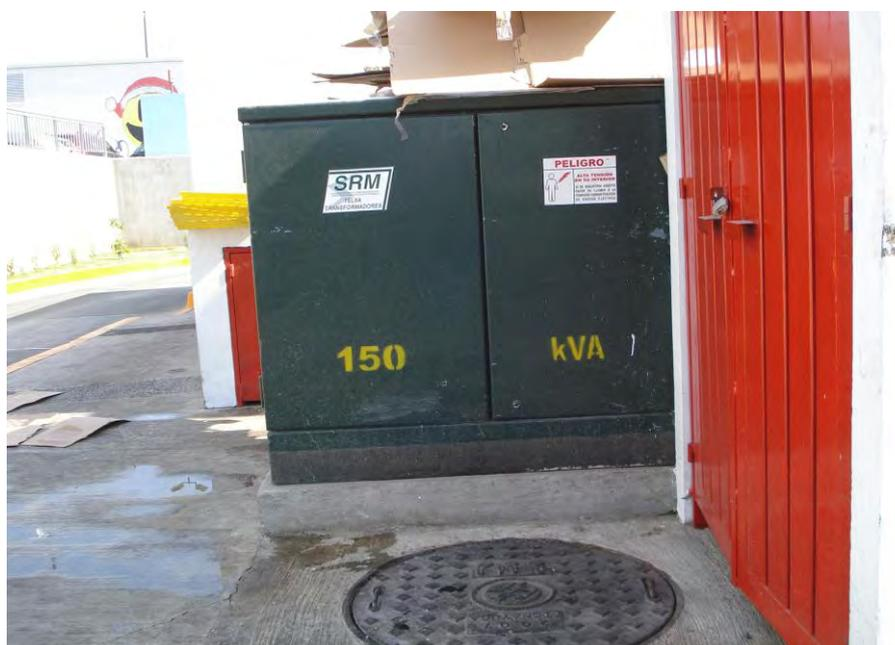
Figura 2.22 Subestación eléctrica tipo pedestal.
