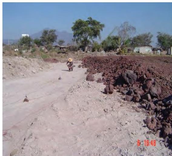
Figura 3.4 Colocación de los electrodos de prueba.
