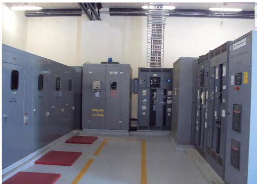
Figura 2.21 Subestación eléctrica tipo interior.
