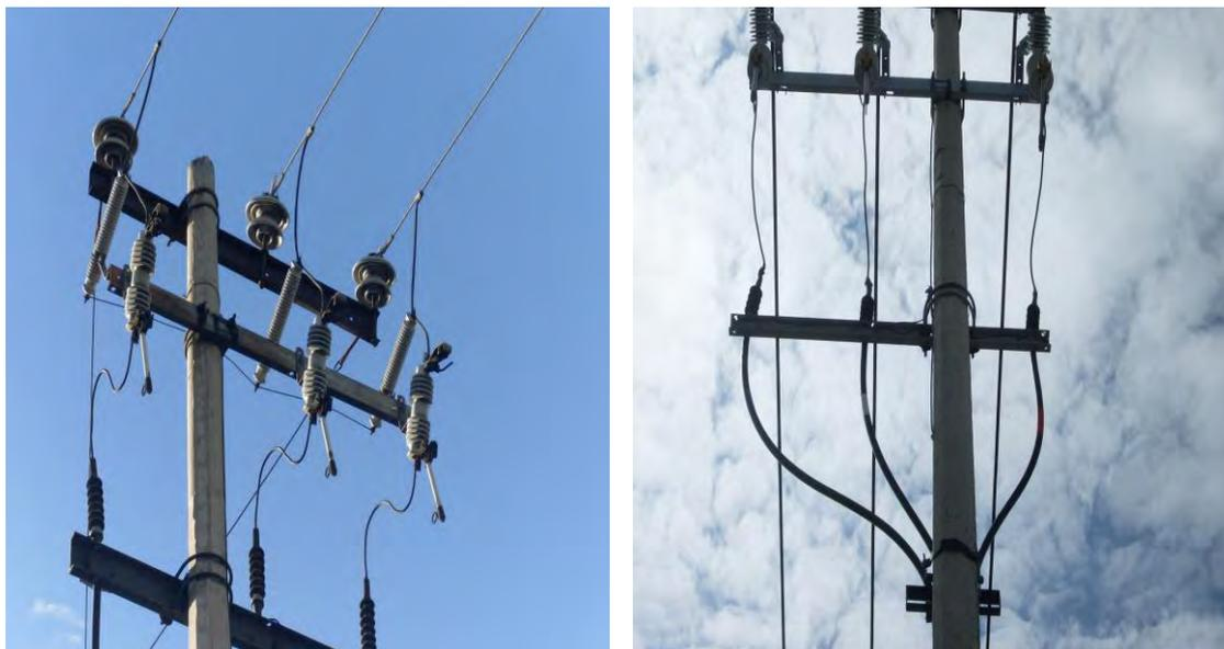
Figura 2.18 Acometida y transición de área-subterránea en M.T.
