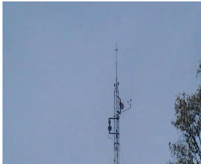
Figura 3.30 Punta pararrayos dipolo corona en torre de comunicaciones.
