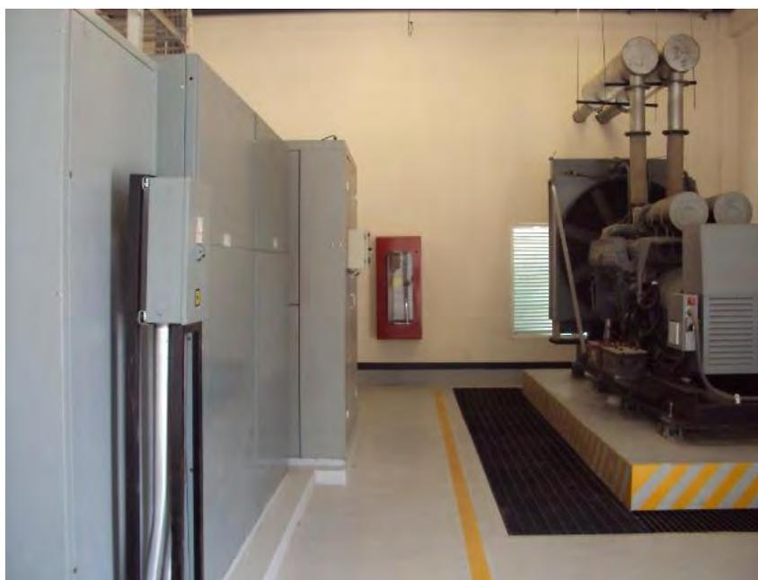
Figura 2.24 Planta de emergencia y gabinetes de subestación.
