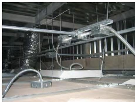
Figura 1.2 Instalación eléctrica parcialmente oculta
