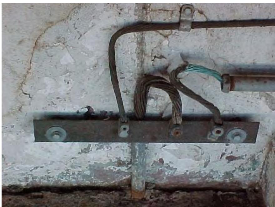
Figura 3.14 Barra de puesta a tierra en mal estado.
