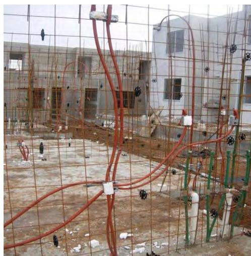
Figura 2.7 Cajas chalupa usada como caja de conexiones.
