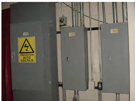
Figura 1.1 Instalación eléctrica aparente.
