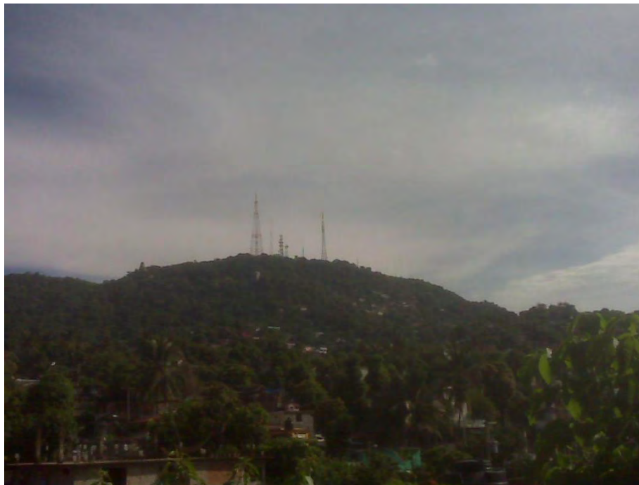
Figura 29 -Antena BH (Colonia 20 de Noviembre).
