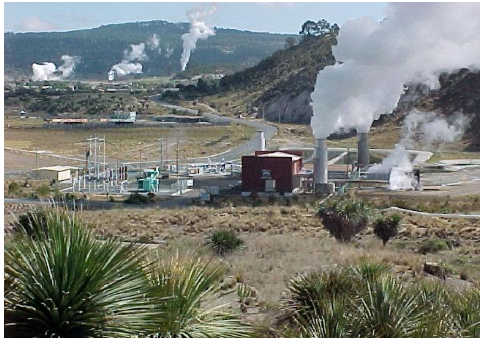
Figura 1.33.- Campo geotérmico “Los Hornos” 30
