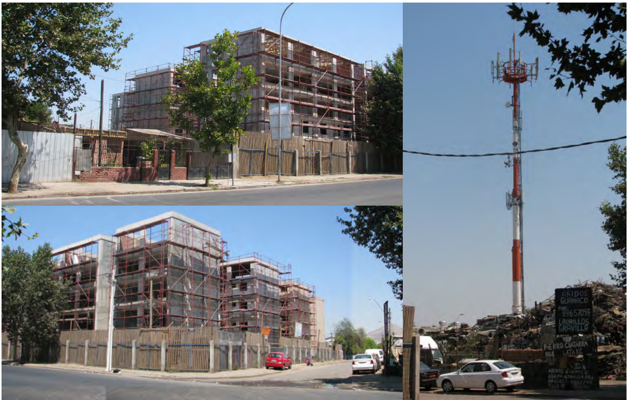
Fig.103, 104 Edificio de departamentos en construcción en ex escuela Santa Clara Fig.105 Terreno ocupado por depósito de chatarra y antena de celular.
