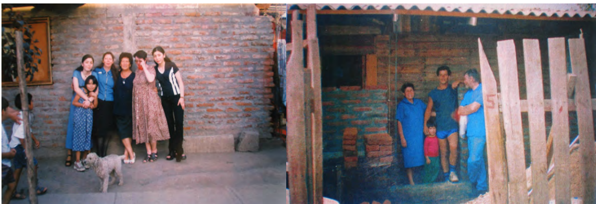
Fig.74 Exterior de casas construidas por autoconstrucción con apoyo de ONG extranjera en el Campamento Parque Santa Mónica. Fuente: archivo personal Noelia Jofré.
