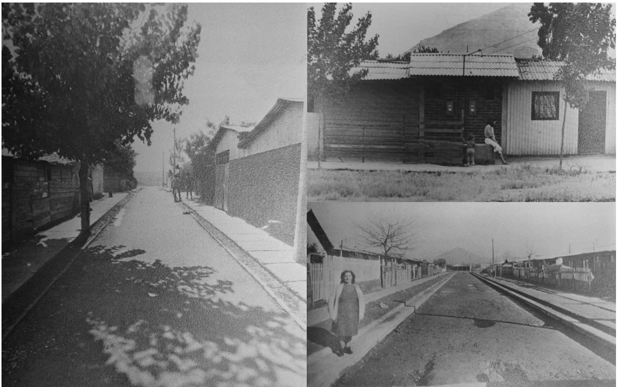
Fig. 63 -64 - 65 Serie de fotografías tomadas por el municipio en el momento de la ejecución del programa de Casetas Sanitarias. En el pie de página de la fotografía se lee: "La caseta sanitaria va ordenando la fachada, la calle, la villa La Araucanía (ex- Santa Mónica)". Fuente: Ilustre Municipalidad de Conchalí: "Plan de desarrollo de Conchalí" (PLADE). Santiago. Año 1987.
