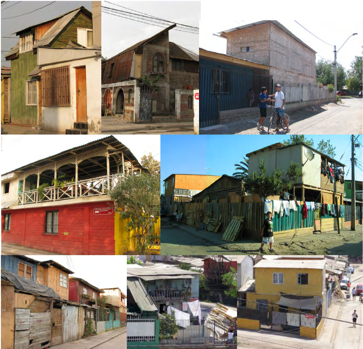
Fig.73 Serie de fotografías de casas autoproducidas por los pobladores en la población Araucanía y Santa Mónica. Pueden verse soluciones aún precarias, otras bastante mejoradas en el tiempo. Otras se niegan a la calle, otras se abren a ella con jardines. En otras se aprecia el hacinamiento y la falta de espacio interior que hace sacar a la calle algunas actividades. Todas ellas constituyen la diversidad y "complejidad organizada" de la imagen urbana popular. 2008-2009.
