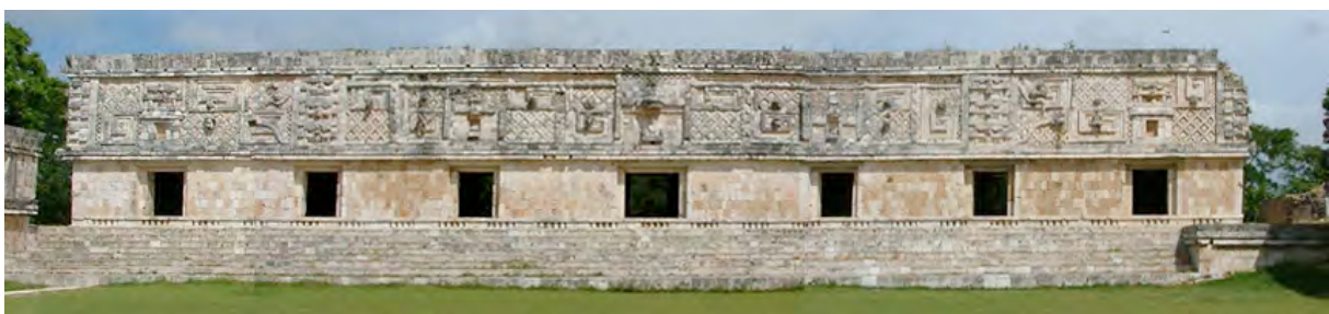
Figura 119. Edificio oriente en el cuadrángulo de las monjas Uxmal
