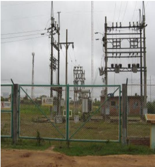
Figura 2.6: Subestación eléctrica.
