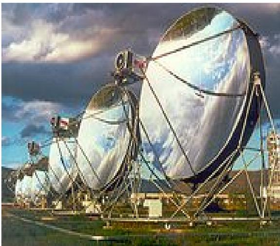
**Figura1.15: Colectores solares parabólicos concentran la radiación solar aumentando temperatura en el receptor**
