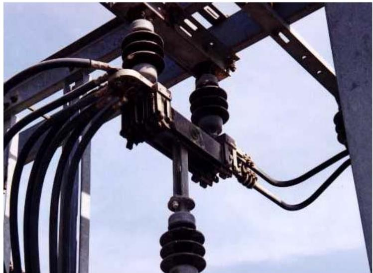
Figura 4.27: Se muestra un seccionador simple instalado en la Línea "A"
