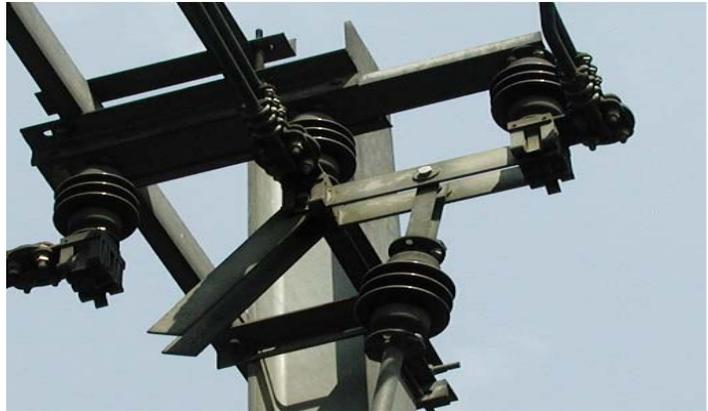
Figura 4.42: Aislado de porcelana instalado en un soporte de La línea "A"
