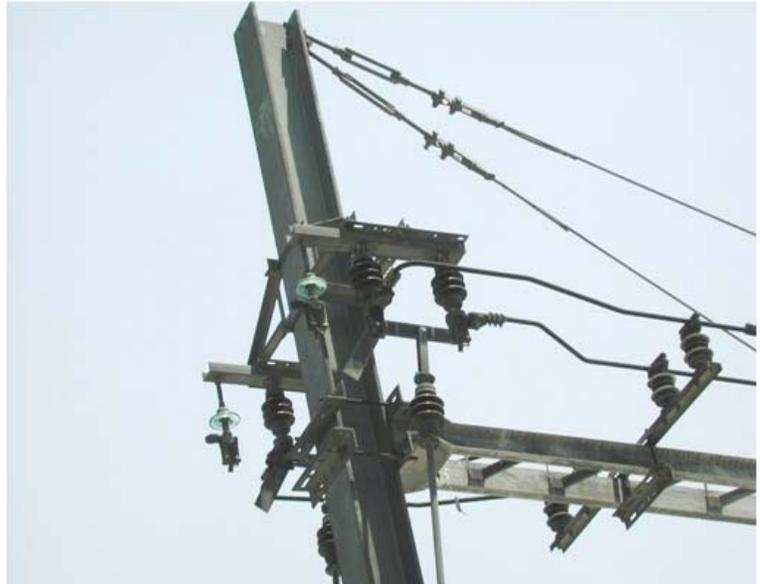
**Figura 4.28:** Se muestra un seccionador con talón de puesta a tierra instalado en La línea "A"
