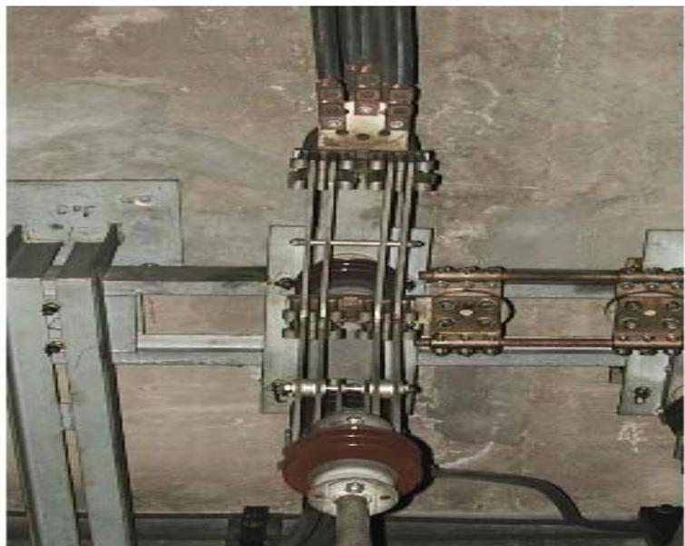
**Figura 4.29:** se muestra en la figura un seccionador inversor instalado en La línea "A"
