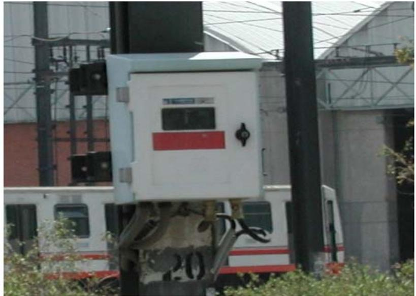
Figura 4.32: Caja de presencia instalada en la zona de los talleres de La Paz
